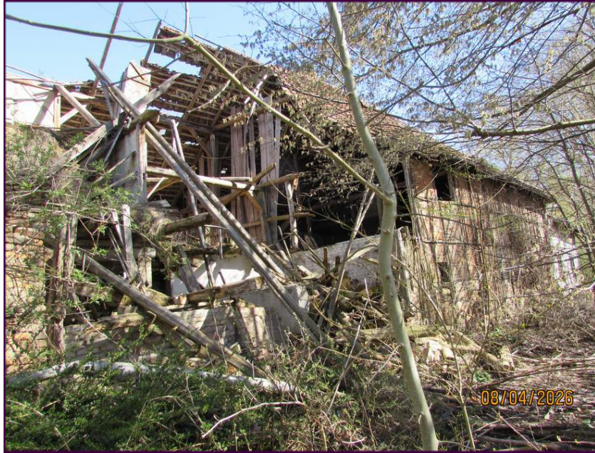
Abbildung 7: Ansicht des ehem. Scheunengebäudes.
