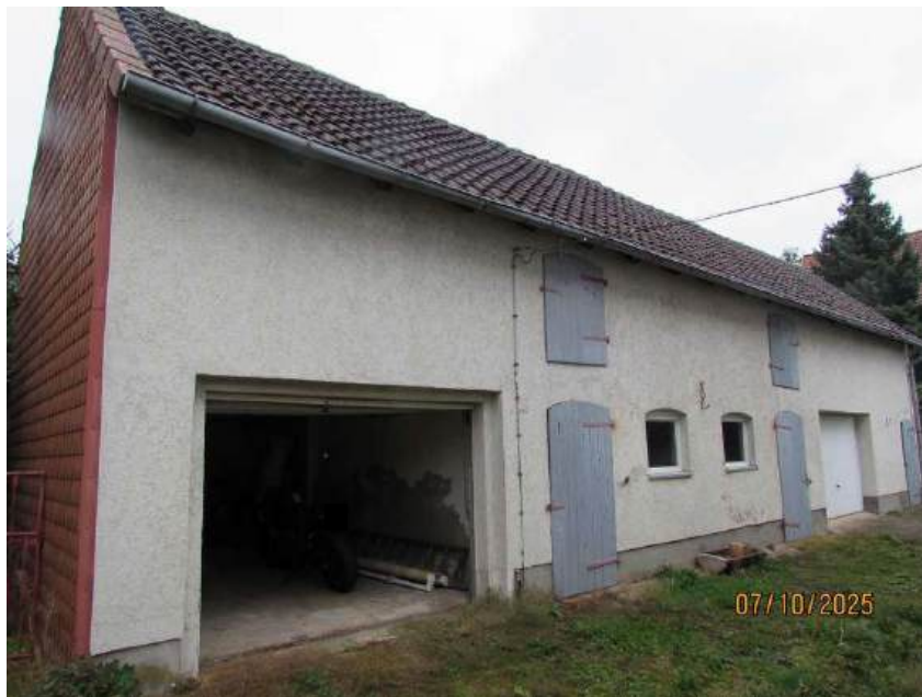
Abbildung 7: Blick auf das hofseitige Nebengebäude.
