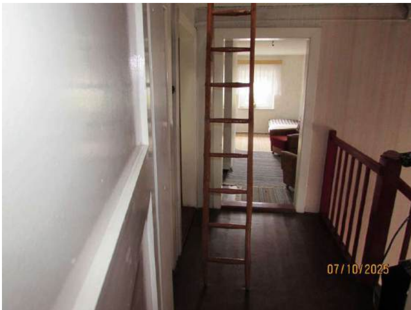
Abbildung 6: Dachgeschoss mit Zugang zur Dachspitze.
