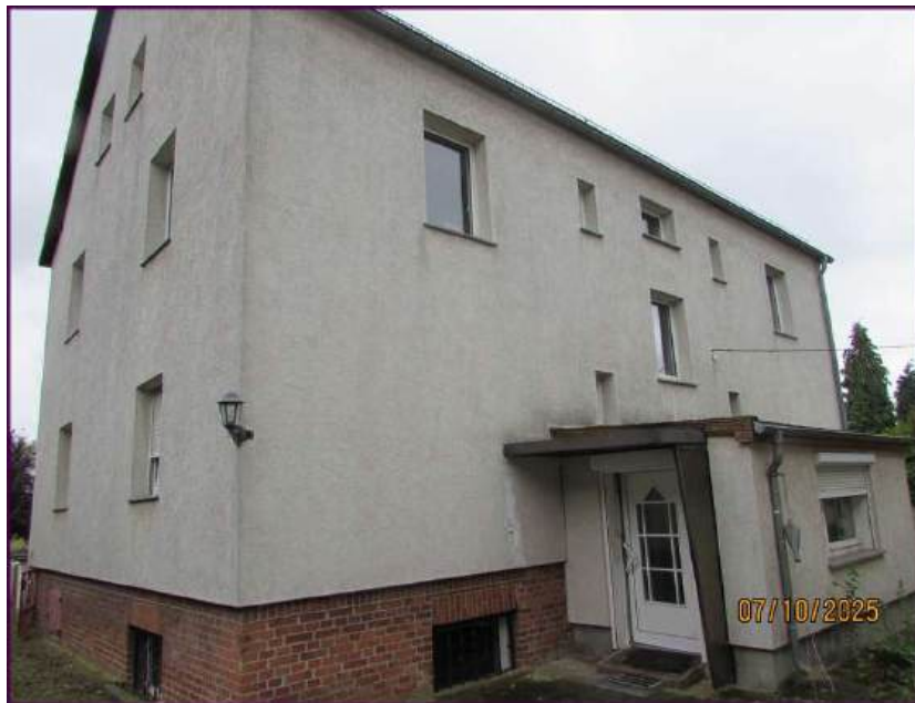
Abbildung 2: Blick vom Innenhof mit Hauszugang.
