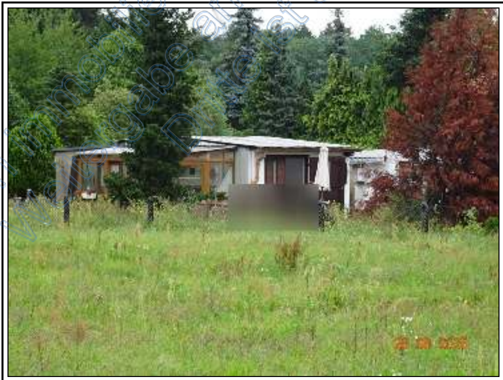
Foto 6: südliche Ansicht des Schuppens und der Garage
