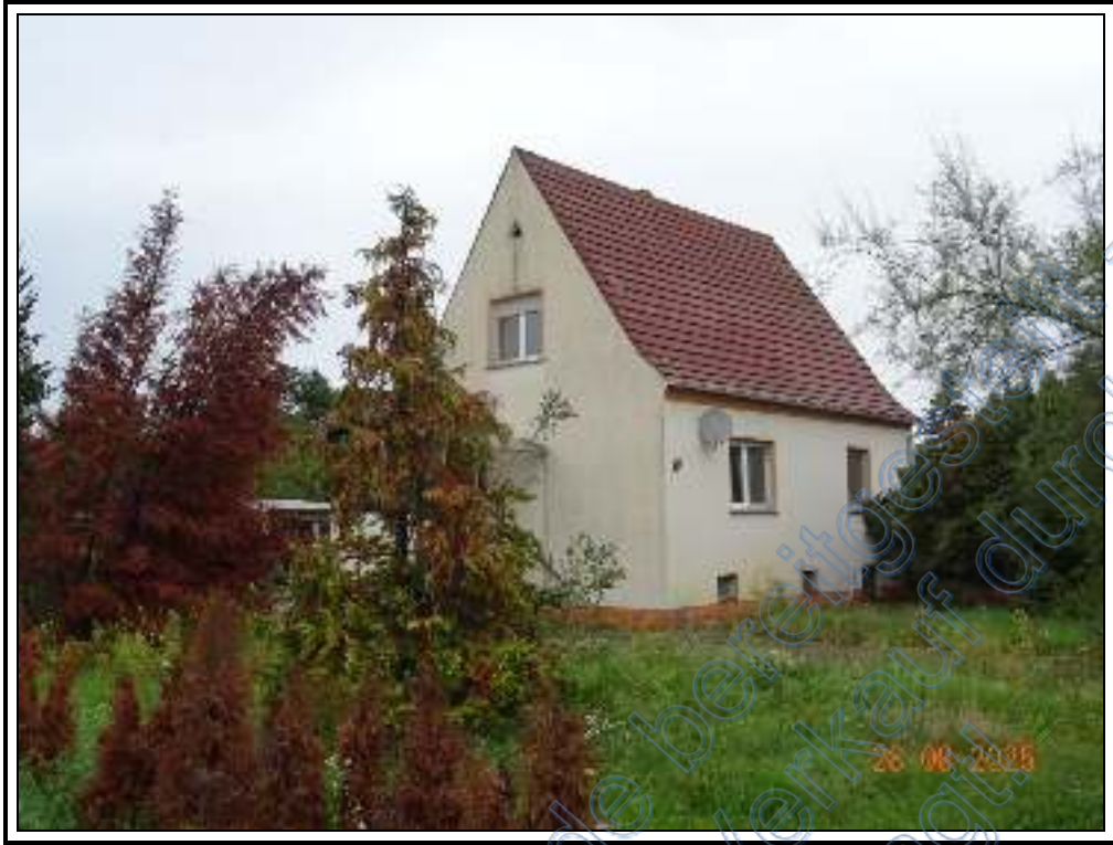
Foto 5: südliche Ansicht des Einfamilienhauses
