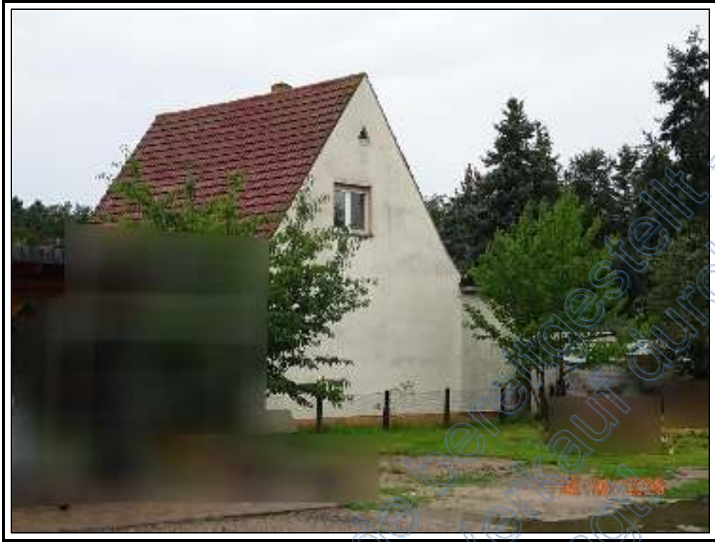
Foto 3: nördliche Ansicht des Einfamilienhauses
