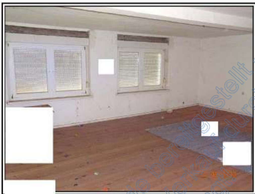
Foto 21: BV Nr. 4 ; straßenseitiger Raum im OG des Wohnhauses
