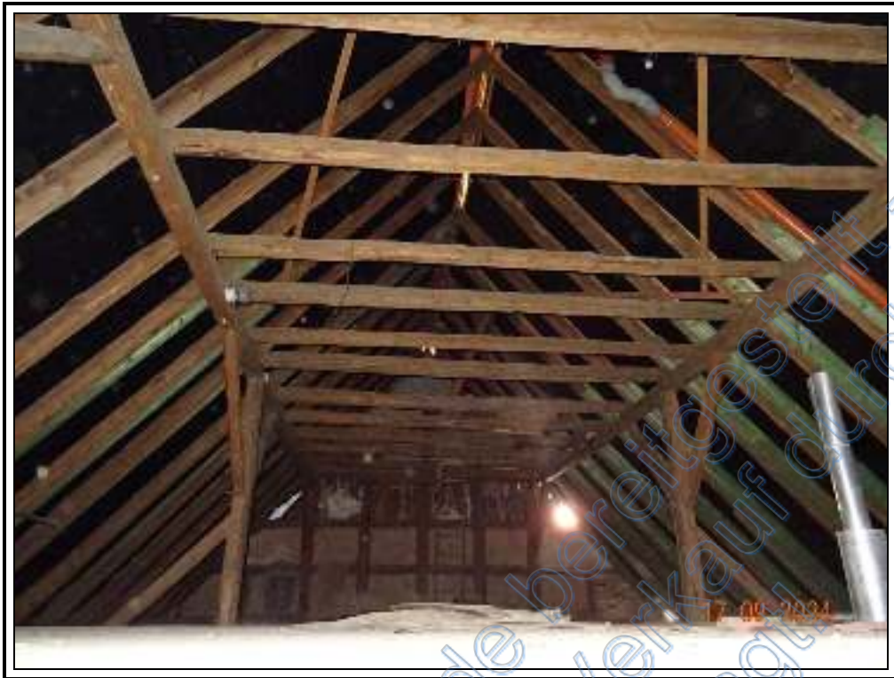
Foto 25: BV Nr. 4 : Lagerraum im DG des Wohnhauses
