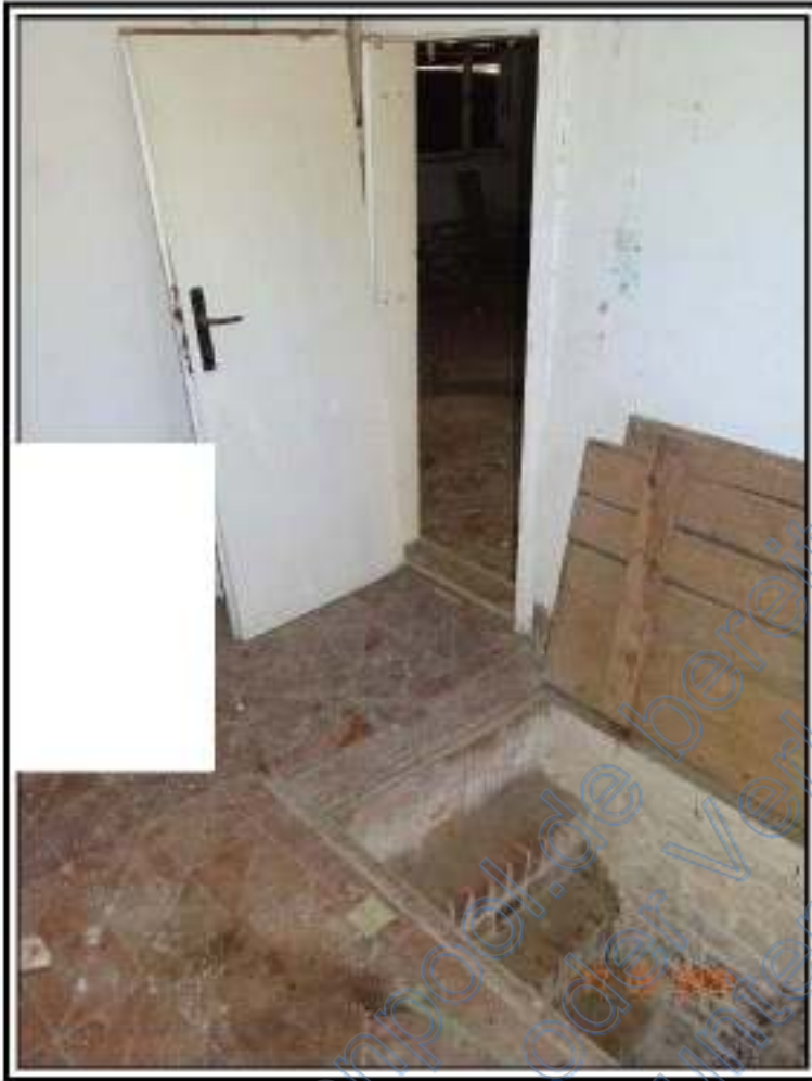
Foto 11: BV Nr. 4: Raum mit Kellertreppe im EG des Wohnhauses
