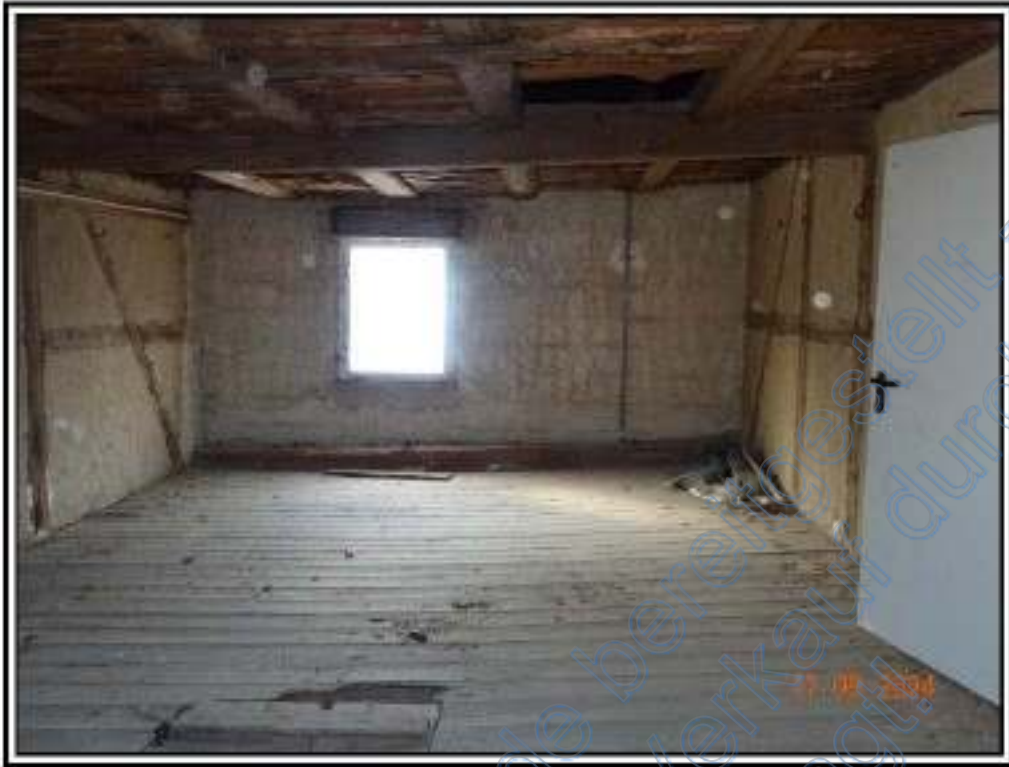
Foto 17: BV Nr. 4 : Vorraum im OG des Wohnhauses
