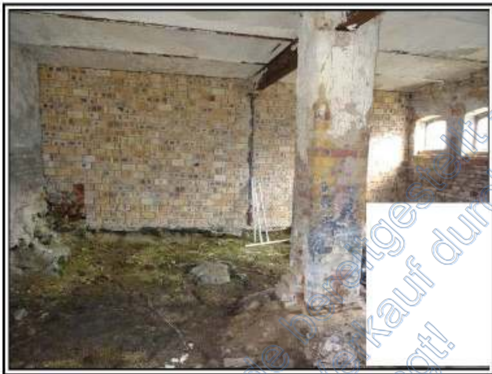
Foto 29: BV Nr. 4 ; Lagerraum im EG des ehemaligen Stalls
