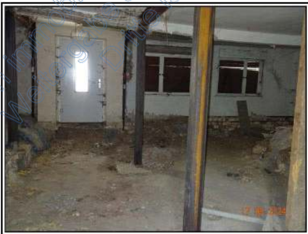
Foto 12: BV Nr. 4: Hauptraum im EG des Wohnhauses
