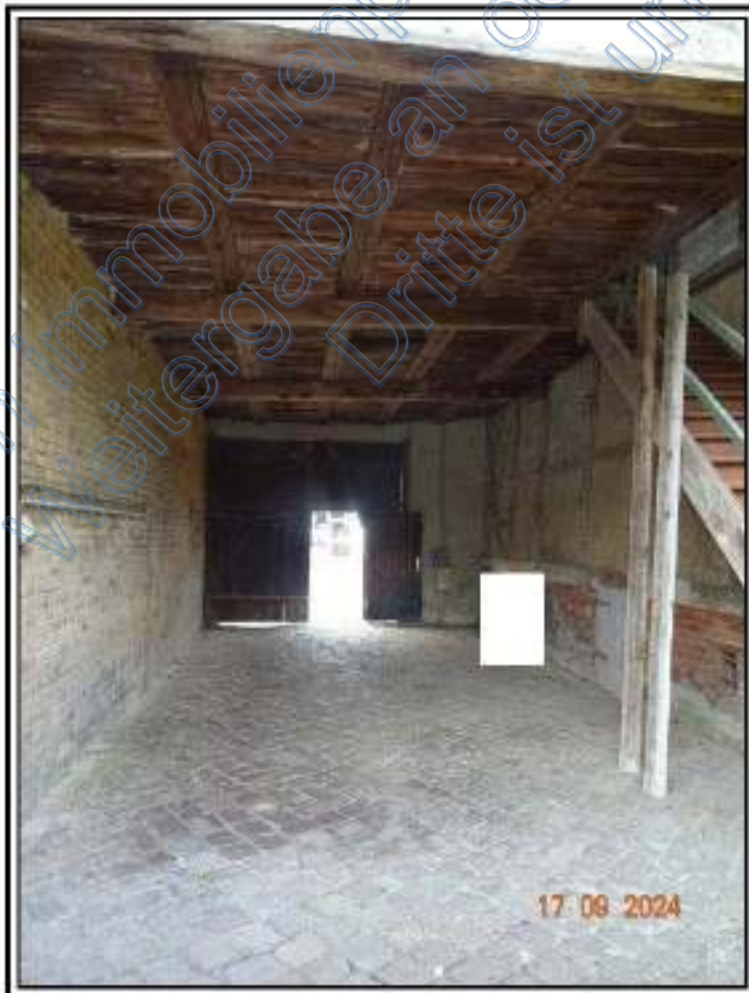
Foto 6: BV Nr. 4 : Durchfahrt im EG des Wohnhauses
