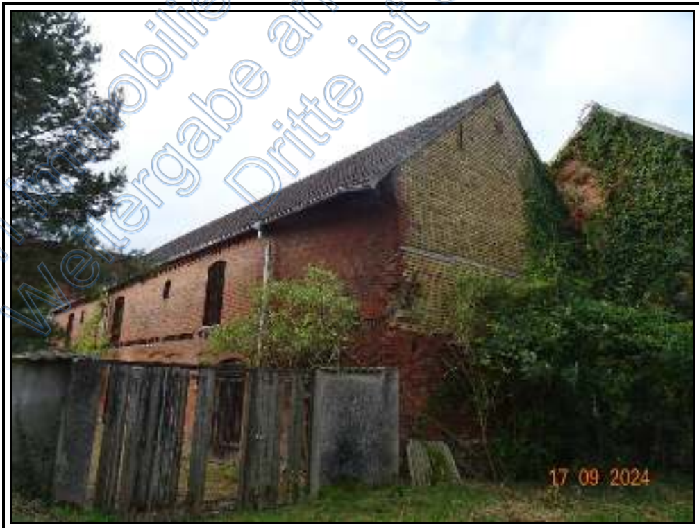
Foto 28: BV Nr. 4 : nordöstliche Ansicht des ehemaligen Stalls
