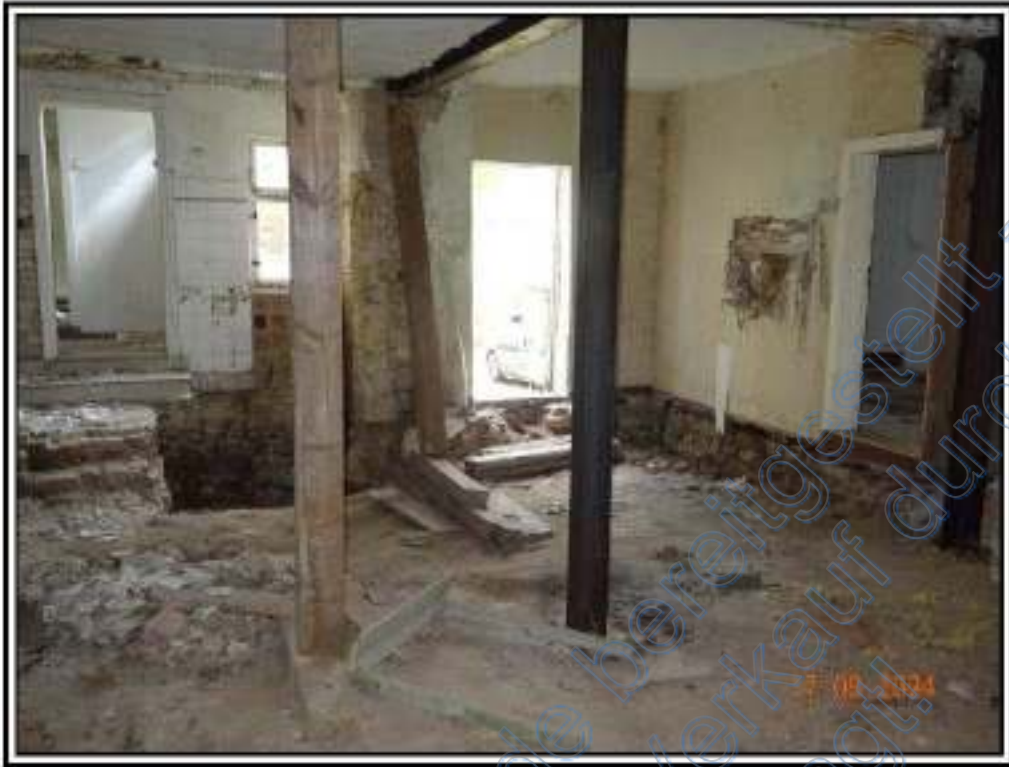
Foto 13: BV Nr. 4 : Hauptraum im EG des Wohnhauses mit Zugang zum Zwischenbau
