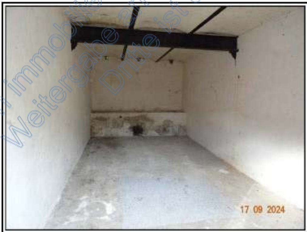
Foto 30: BV Nr. 4 ; Lagerraum im EG des ehemaligen Stalls
