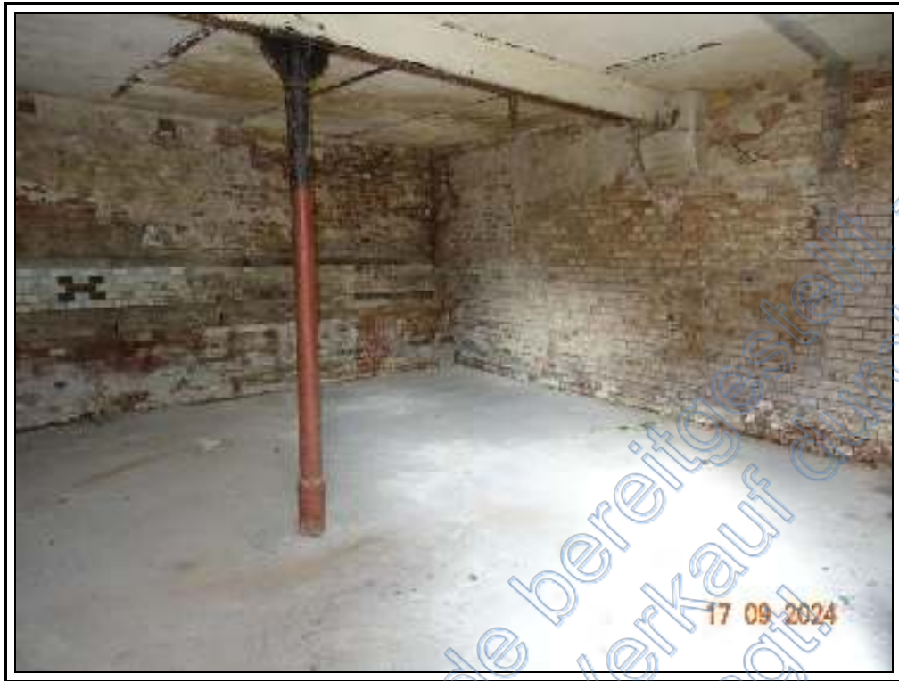
Foto 31: BV Nr. 4 : Lagerraum im EG des ehemaligen Stalls
