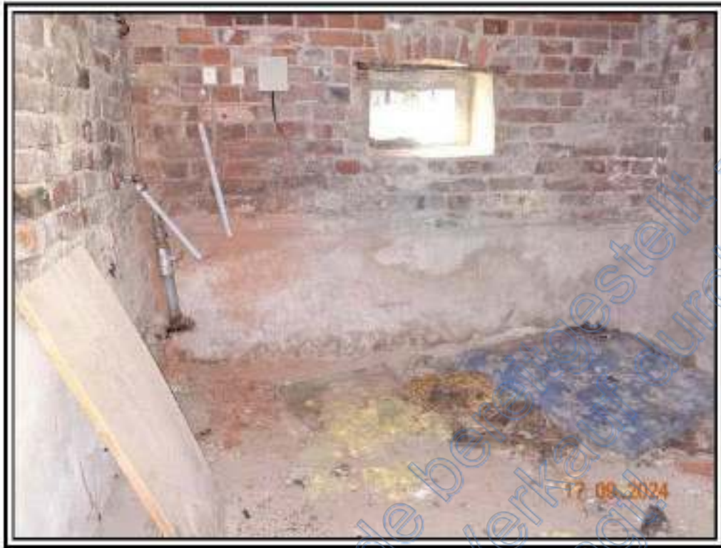
Foto 9: BV Nr. 4 ; Lagerraum im KG des Wohnhauses
