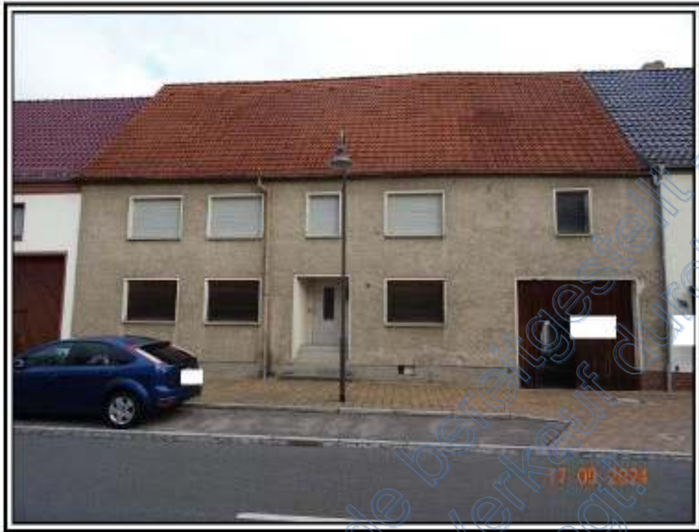
Foto 5: BV Nr. 4 : südliche Ansicht des Wohnhauses
