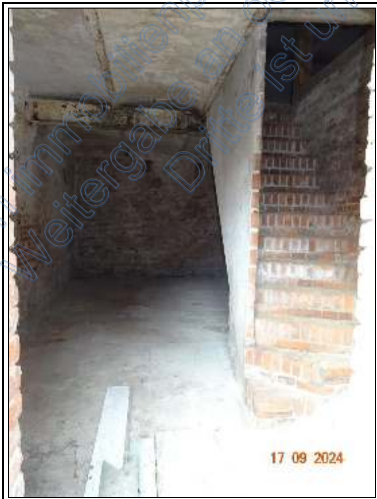
Foto 32: BV Nr. 4 : Lagerraum mit DG-Zugang im EG des ehemaligen Stalls
