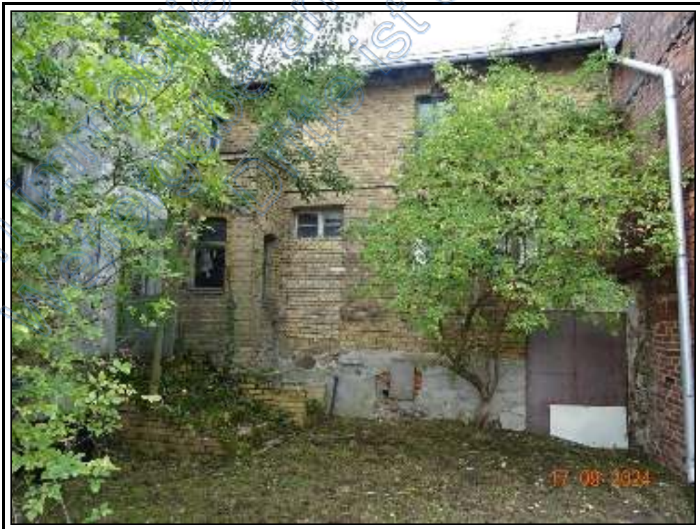
Foto 8: BV Nr. 4 : östliche Ansicht des Zwischenbaus
