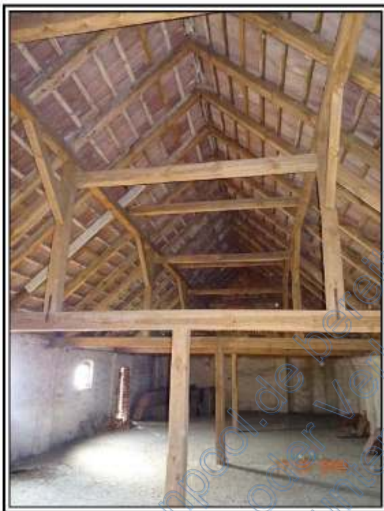
Foto 33: BV Nr. 4: Lageraum im DG des ehemaligen Stalls
