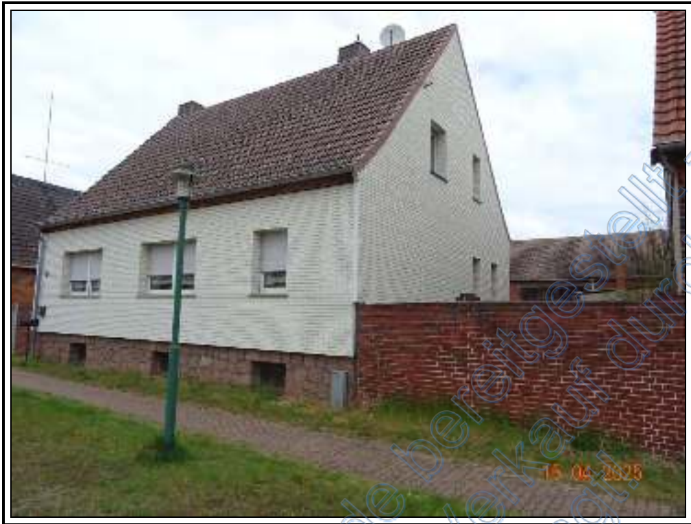
Foto 5: BV Nr. 1 : südöstliche Ansicht des Einfamilienhauses (EFH)
