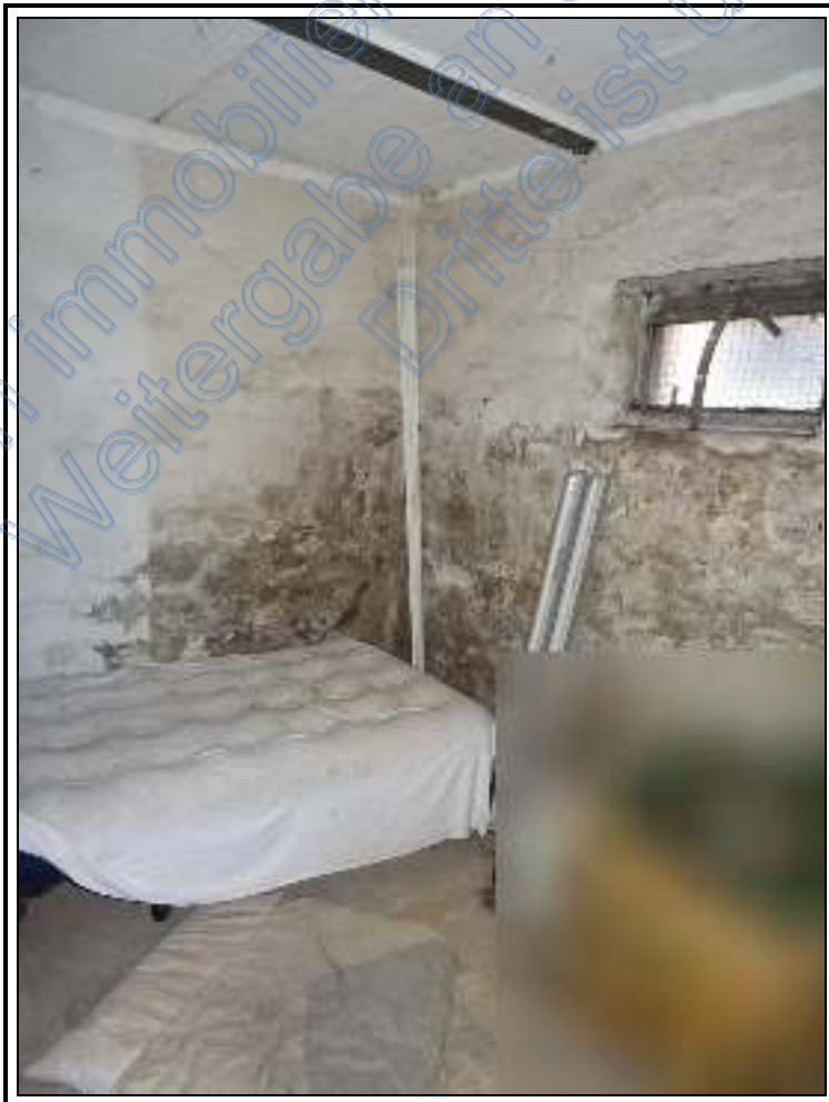
Foto 8: BV Nr. 1: Vorraum zur Kelleraußentreppe im KG des EFH
