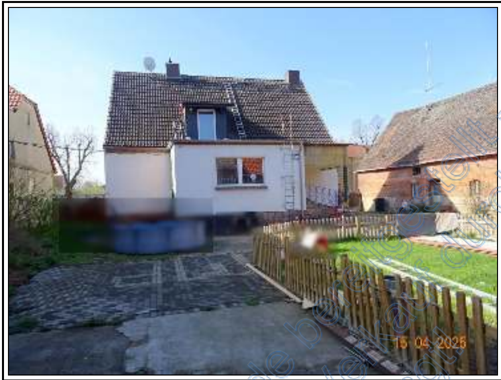
Foto 27: BV Nr. 1 : Hoffläche nördlich des EFH
