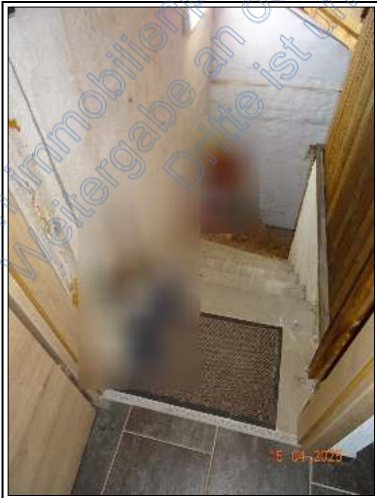
Foto 12: BV Nr. 1 : Kellertreppe des EFH
