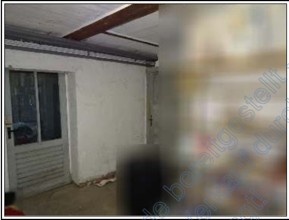
Foto 11: BV Nr. 1 : Vorraum zur Kellertreppe im KG des EFH
