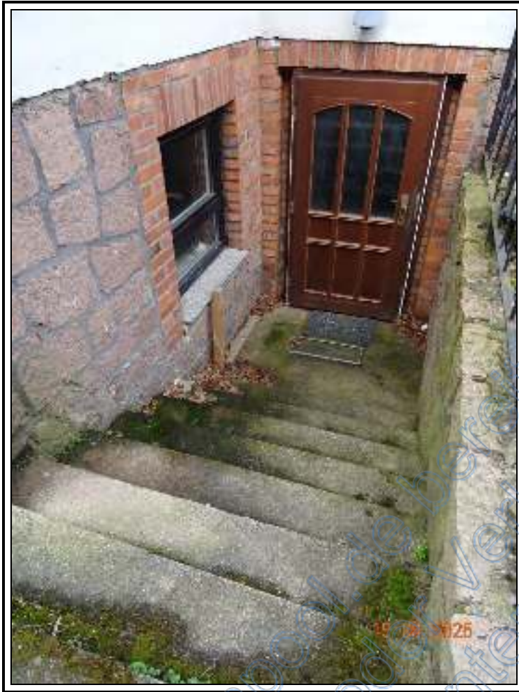
Foto 7: BV Nr. 1: Kelleraußentreppe des EFH
