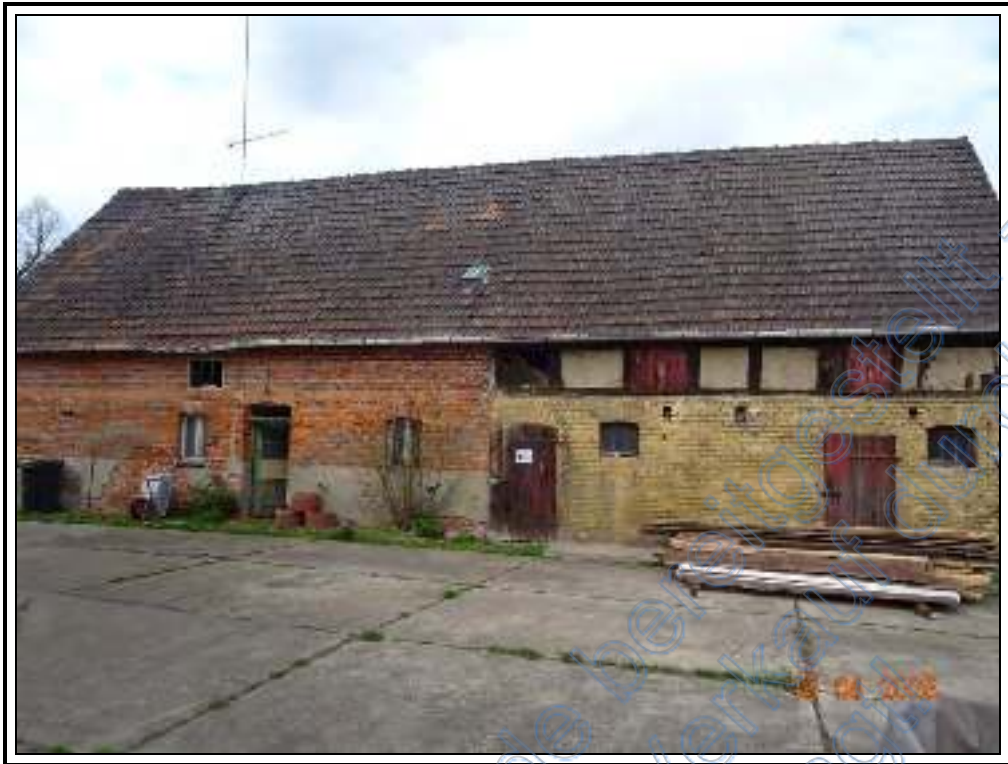
Foto 31: BV Nr. 2 : östliche Ansicht des ehemaligen Stalls mit Auszugshaus
