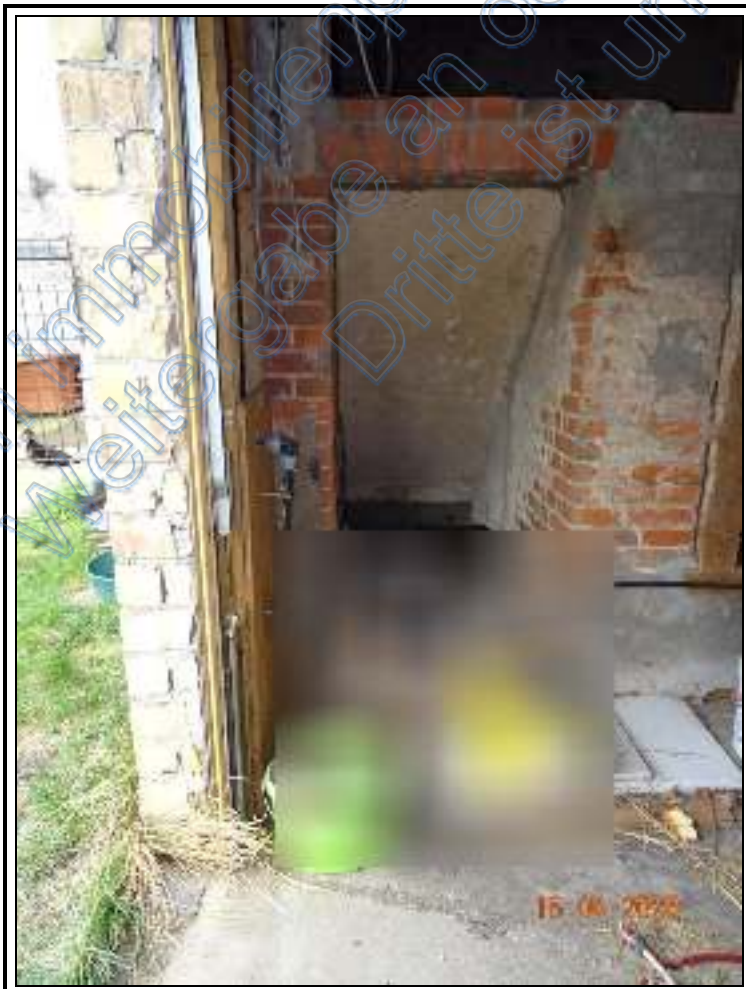
Foto 42: BV Nr. 2 : Zugang zum KG in der ehemaligen Scheune
