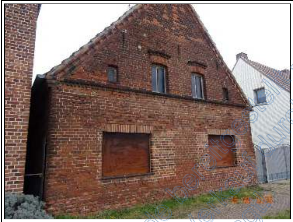
Foto 29: BV Nr. 2 : südwestliche Ansicht des ehemaligen Stalls mit Auszugshaus
