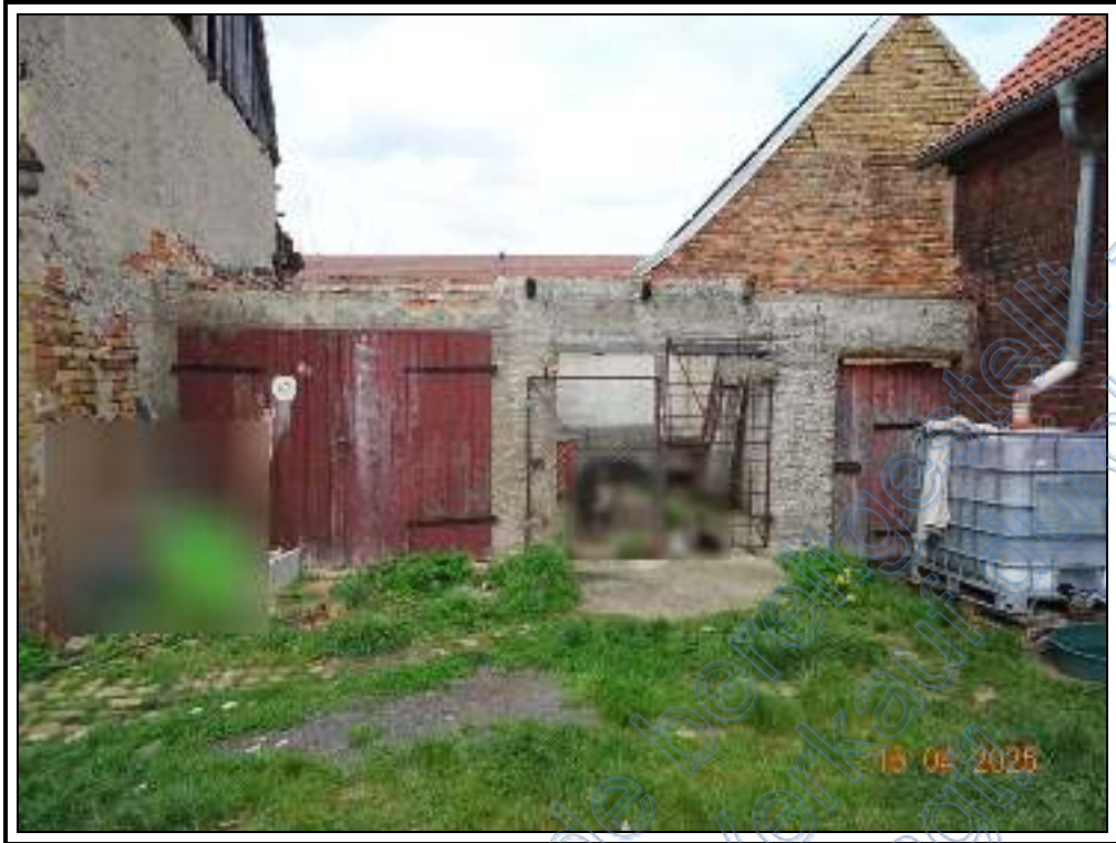
Foto 37: BV Nr. 2 : östliche Ansicht des Hundezwingers mit Garage
