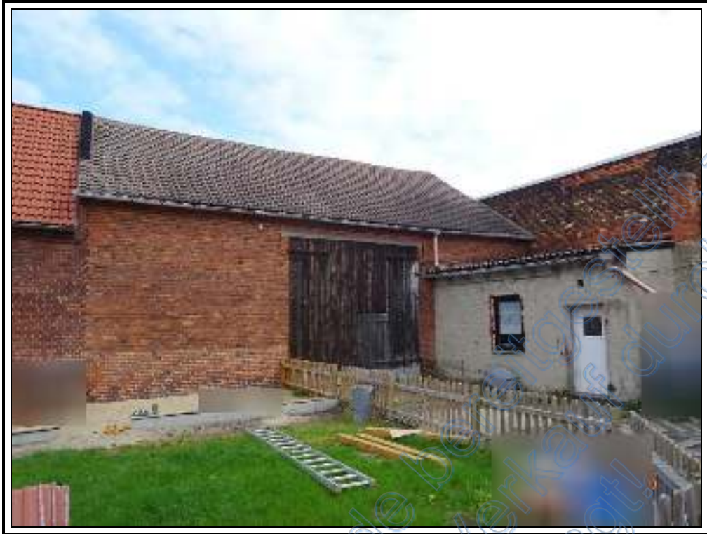
Foto 23: BV Nr. 1 : südwestliche Ansicht der ehemaligen Scheune mit Waschhaus
