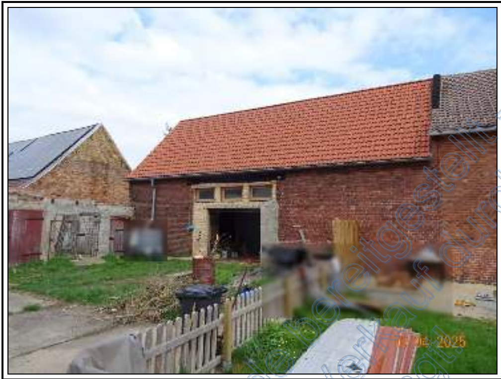
Foto 39: BV Nr. 2 : südwestliche Ansicht der ehemaligen Scheune mit Hühnerstall
