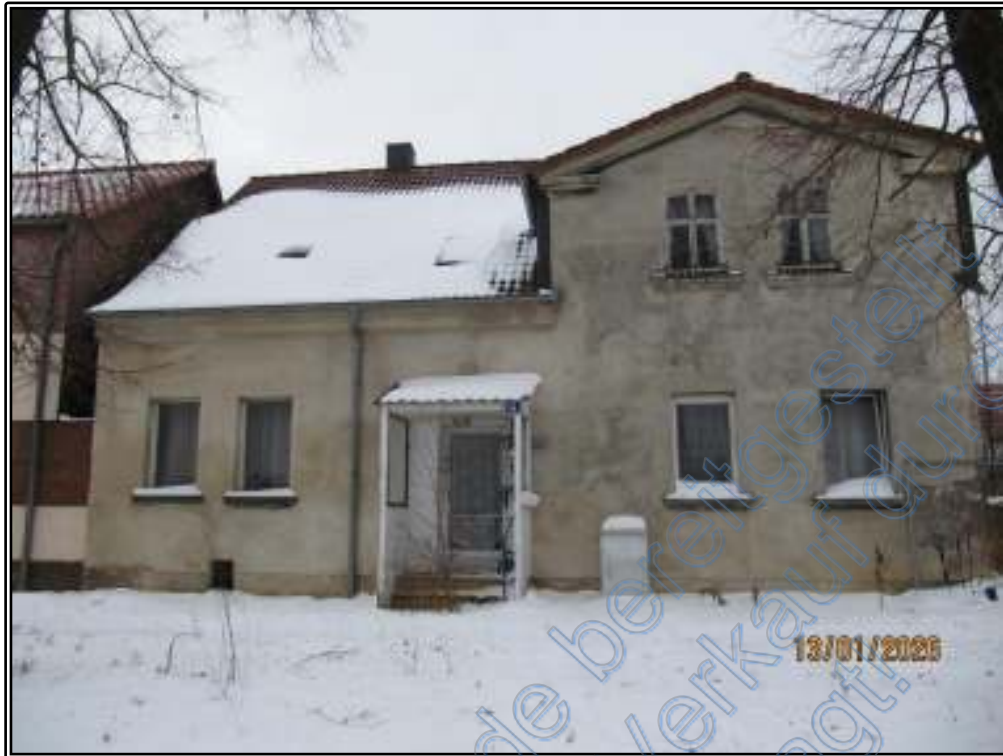
Foto 05: nördliche Ansicht des Wohngebäudes
