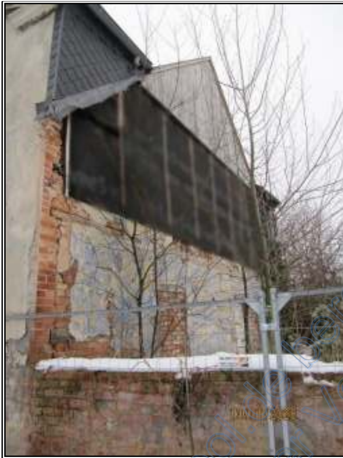
Foto 07: westliche Teilansicht des Wohngebäudes
