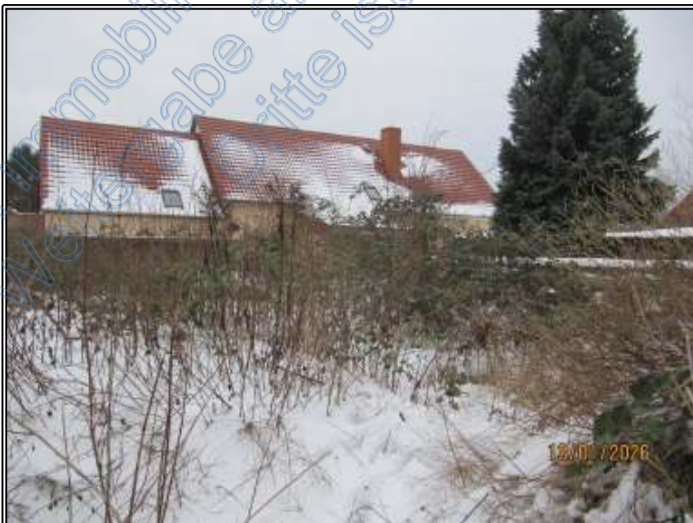
Foto 10: Übersicht über die Grundstücksfreifläche
