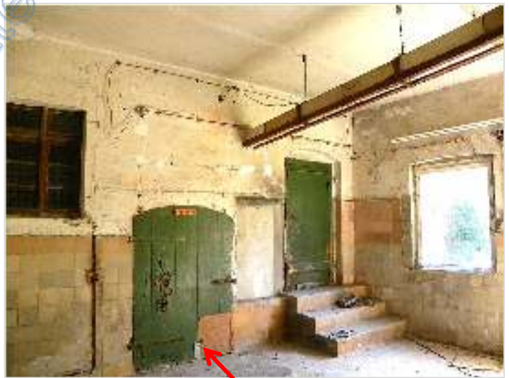
In Nr.1.2.: Zugang in Keller unter dem Wohnhaus
