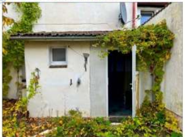
Anbau und Hofausgang
