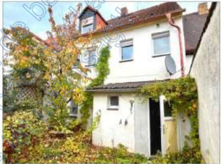
Hinterfront des Wohnhauses und Hof im vernachlässigten Zustand
