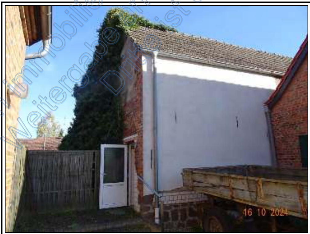
Foto 22: BV Nr. 1 : südwestliche Ansicht des ehemaligen Wirtschaftsgebäudes
