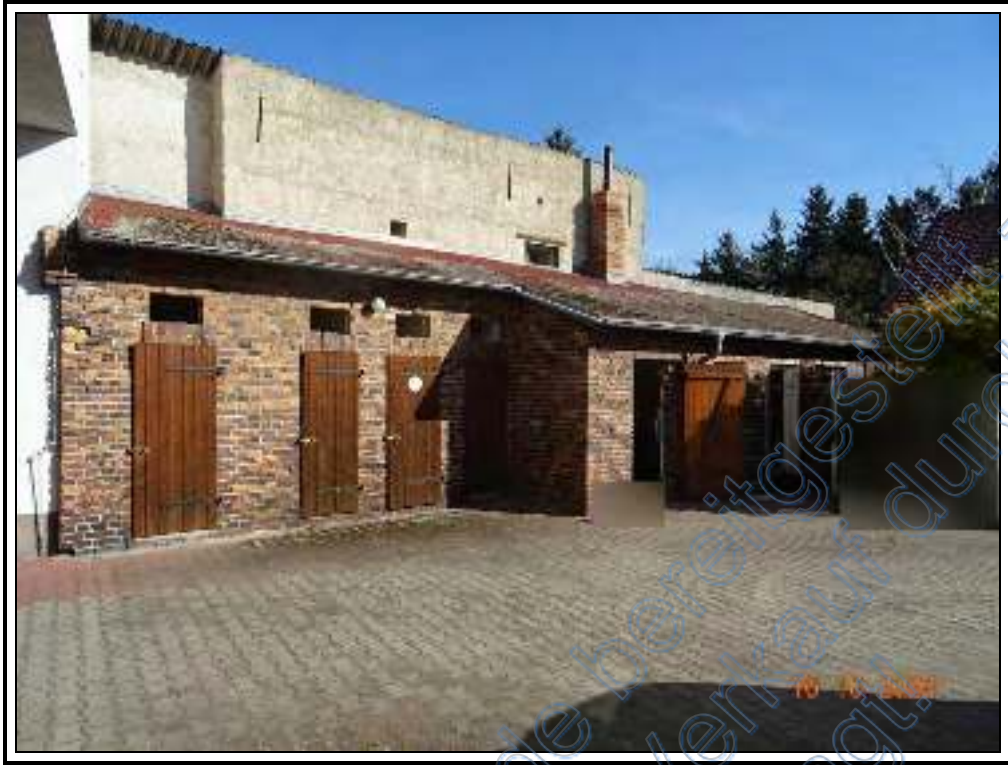
Foto 53: BV Nr. 5 : zentraler Grundstücksbereich
