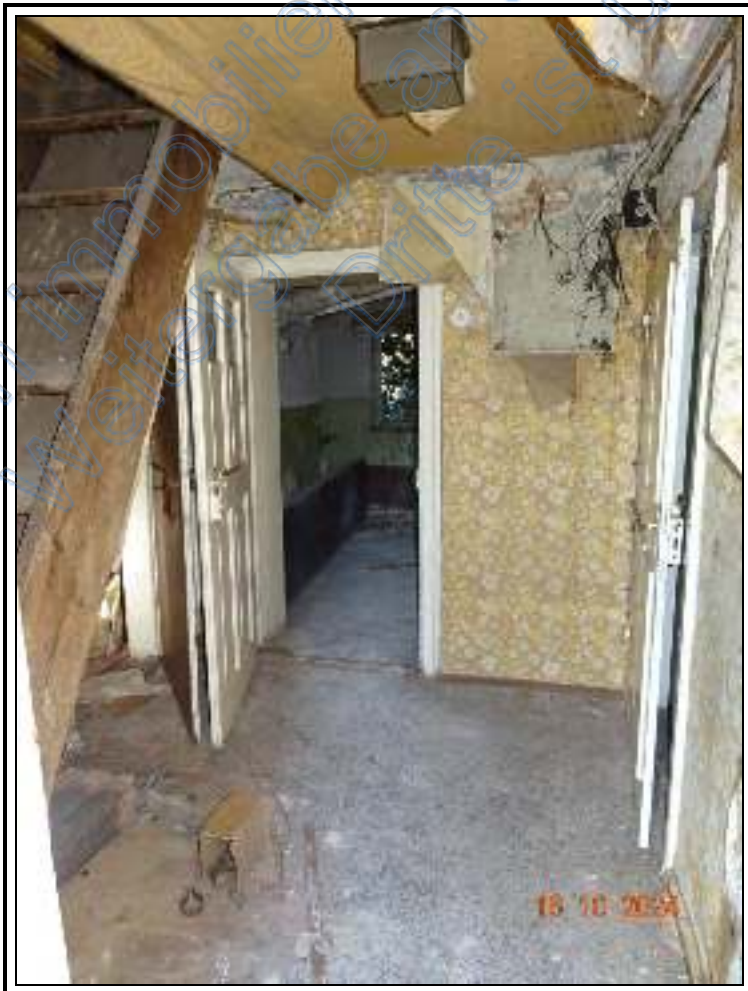
Foto 10: BV Nr. 1 : Diele im EG des ehemaligen Wohn- hauses
