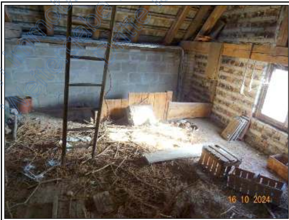
Foto 30: BV Nr. 1 : Kammer/ Abstellraum im DG des ehemaligen Wirtschaftsgebäudes
