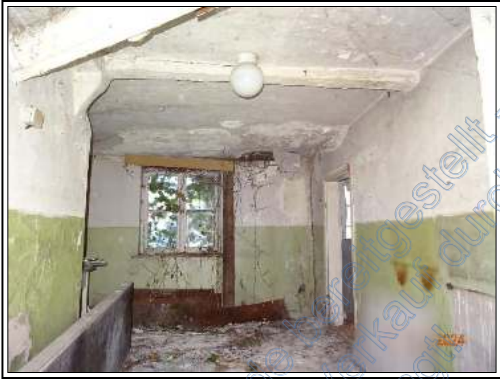
Foto 13: BV Nr. 1 : Küche im EG des ehemaligen Wohnhauses
