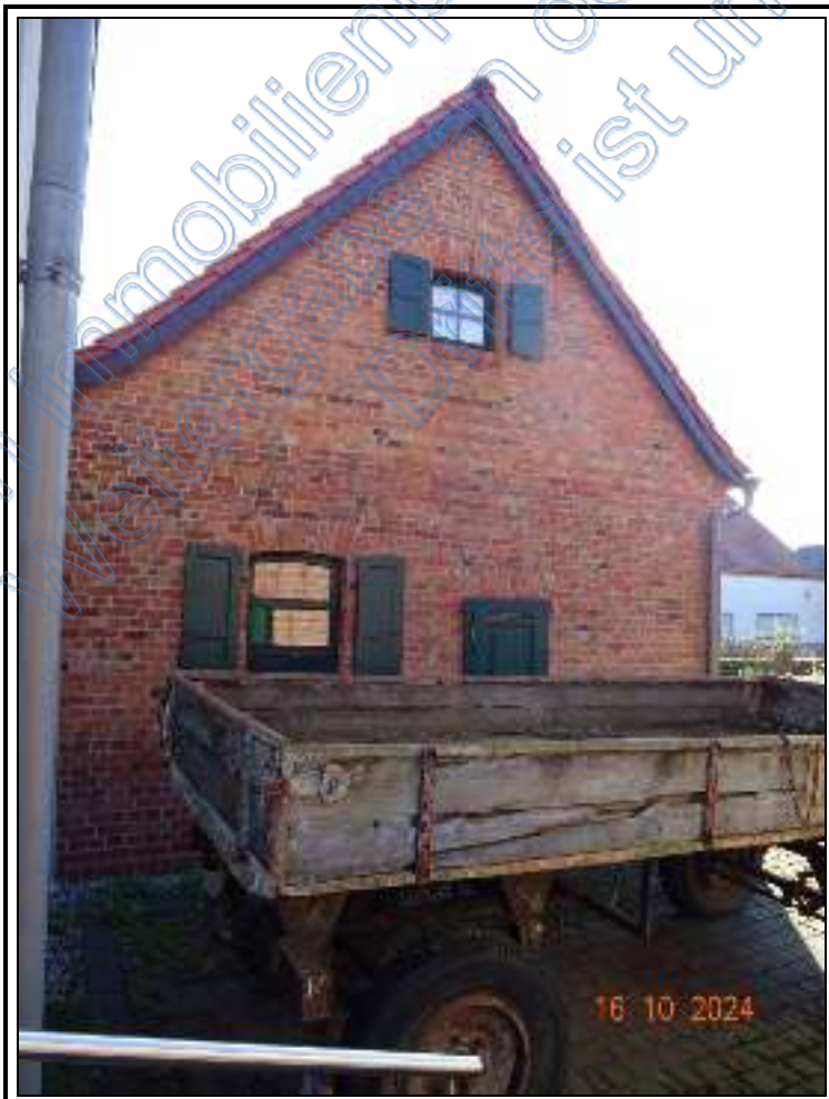
Foto 36: BV Nr. 2 : westliche Ansicht des ehemaligen Werkstattgebäudes
