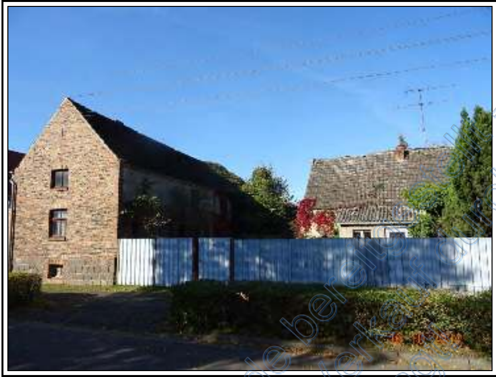
Foto 5: BV Nr. 1 : Grundstücksansicht
