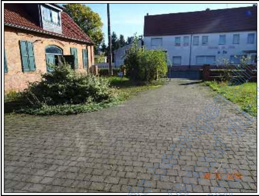
Foto 45: BV Nr. 2 : Freifläche im südöstlichen Grundstücksbereich
