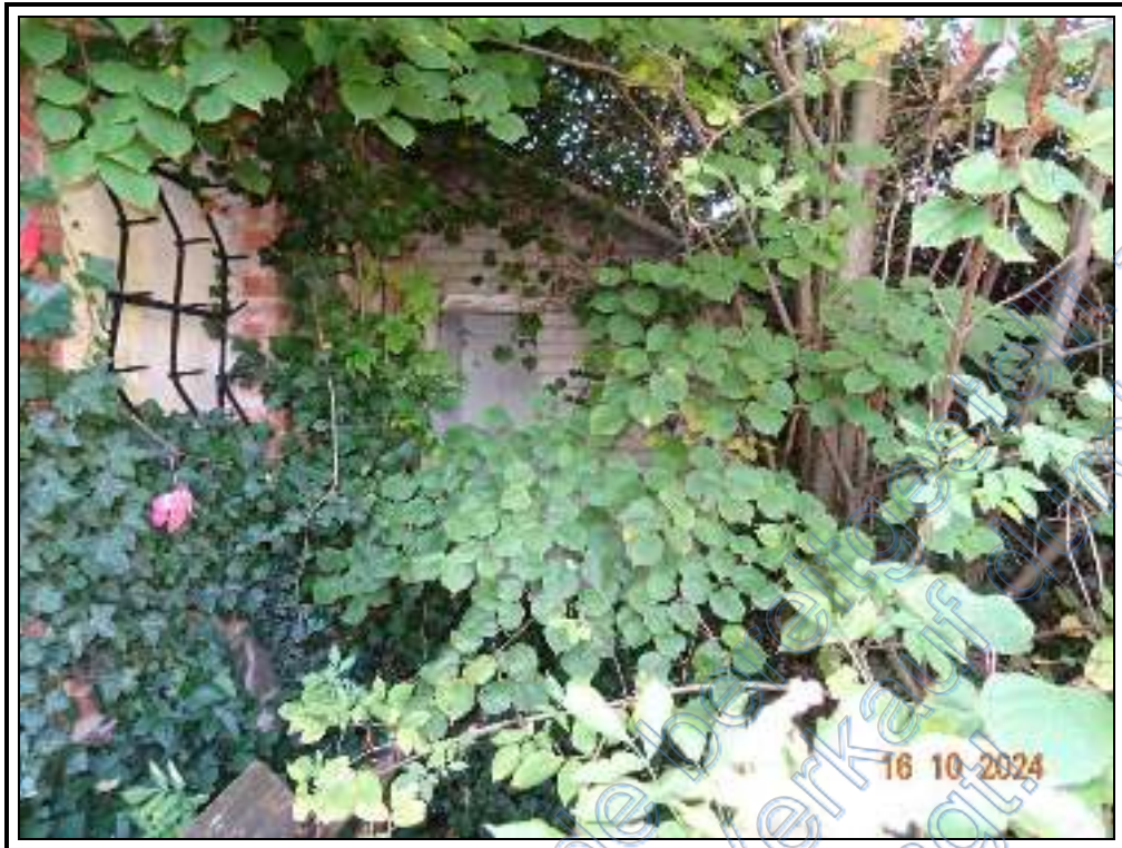
Foto 21: BV Nr. 1 : nordwestliche Teilansicht des ehemaligen Wirtschaftsgebäudes
