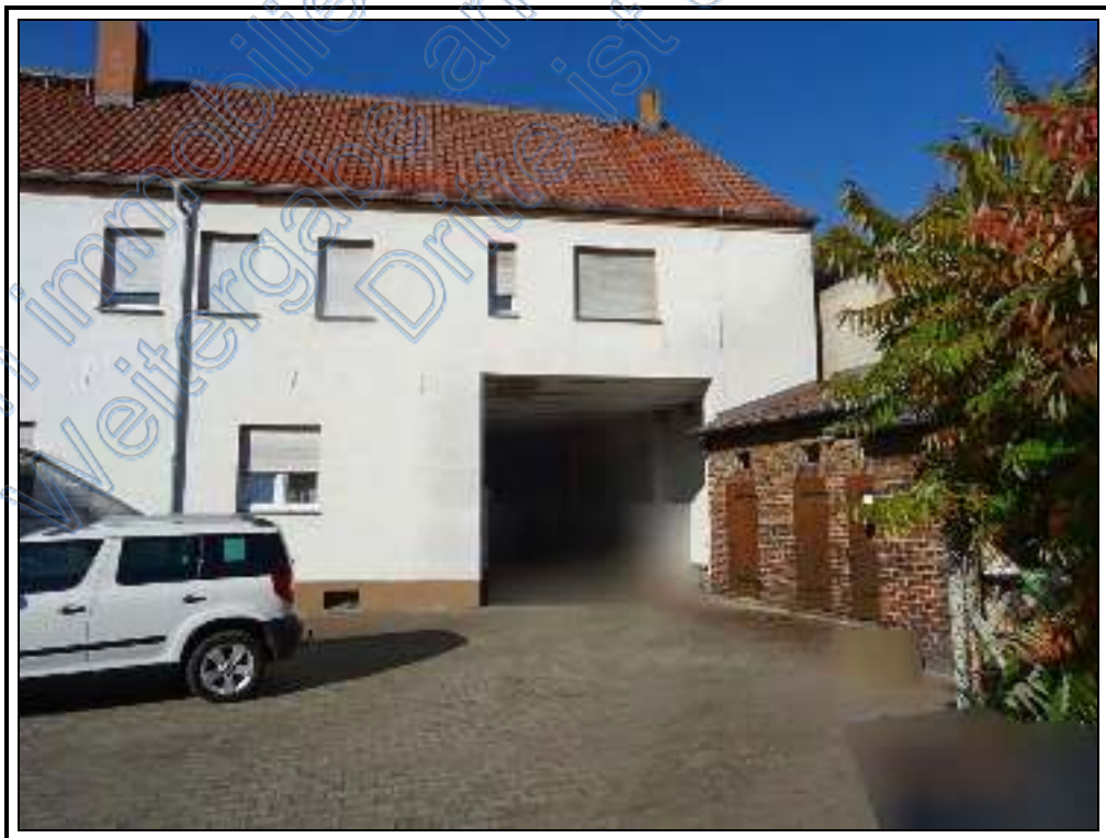
Foto 52: BV Nr. 5 : westlicher Grundstücksbereich
