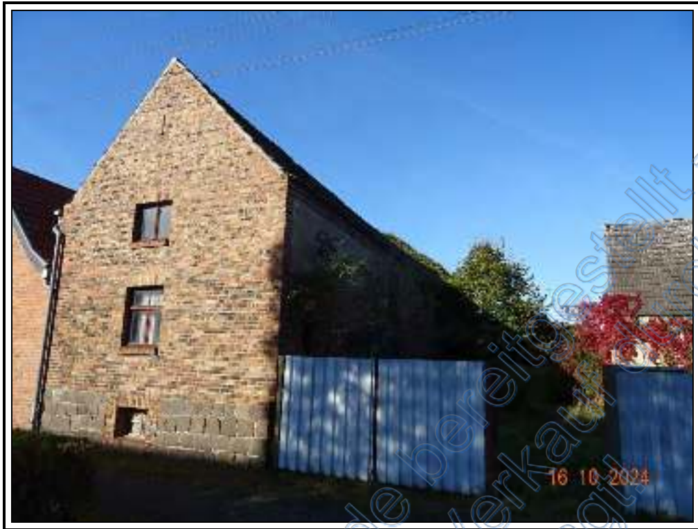
Foto 19: BV Nr. 1 : nordöstliche Ansicht des ehemaligen Wirtschaftsgebäudes
