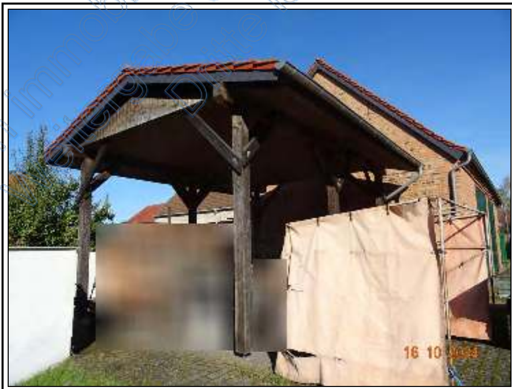
Foto 44: BV Nr. 2 : Lagerüberdachung
