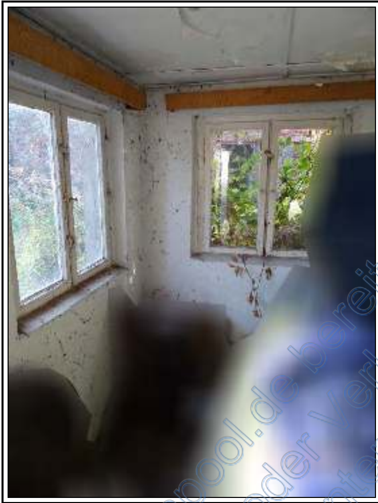
Foto 9: BV Nr. 1 : Windfang im EG des ehemaligen Wohnhauses
