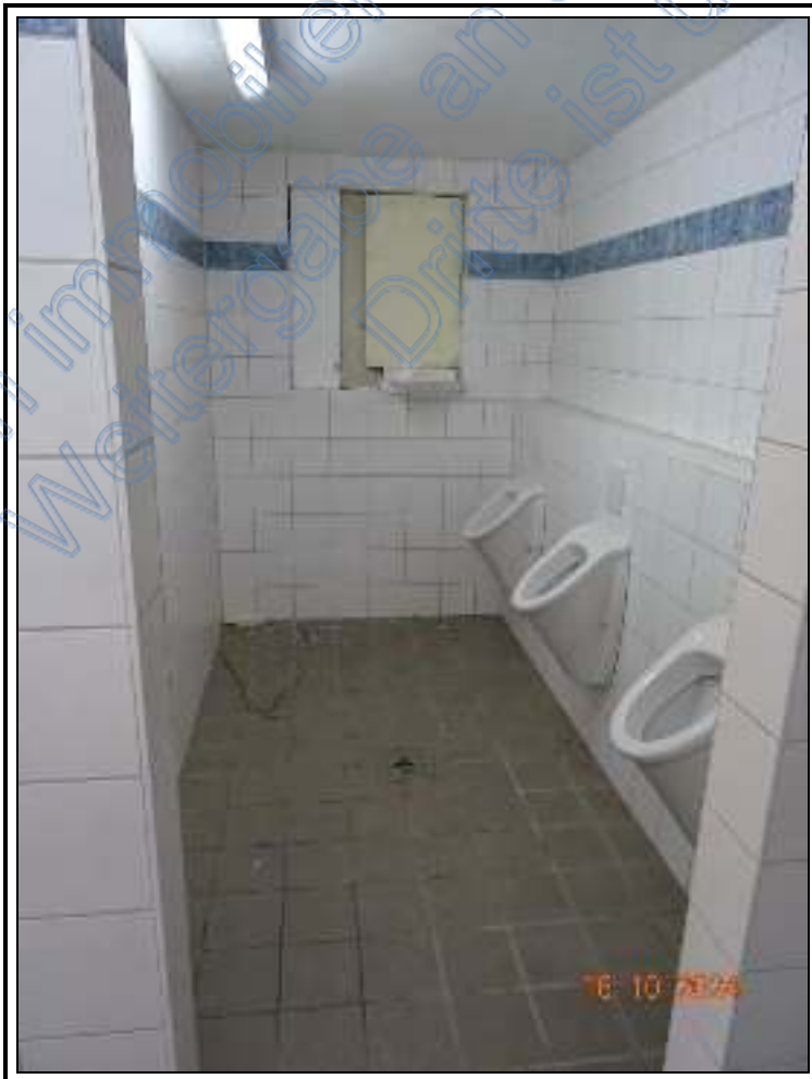
Foto 26: BV Nr. 1 : WC-Männer im EG des ehemaligen Wirtschaftsgebäudes
