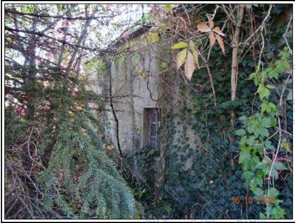
Foto 7: BV Nr. 1 : westliche Ansicht des ehemaligen Wohnhauses
