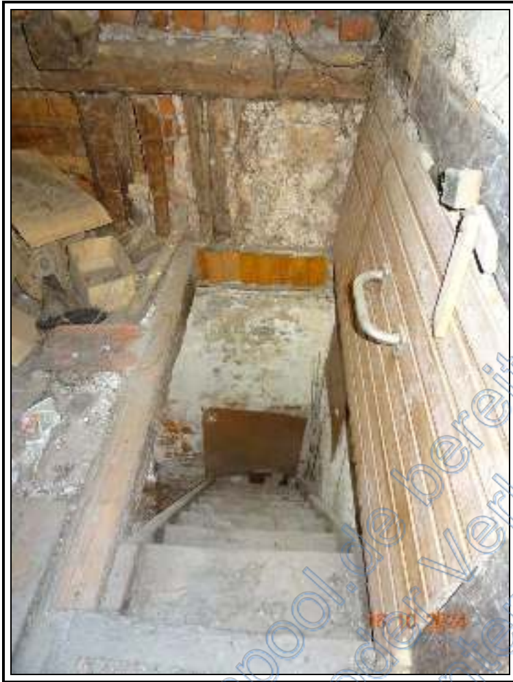
Foto 15: BV Nr. 1 : Geschosstreppe des ehemaligen Wohnhauses
