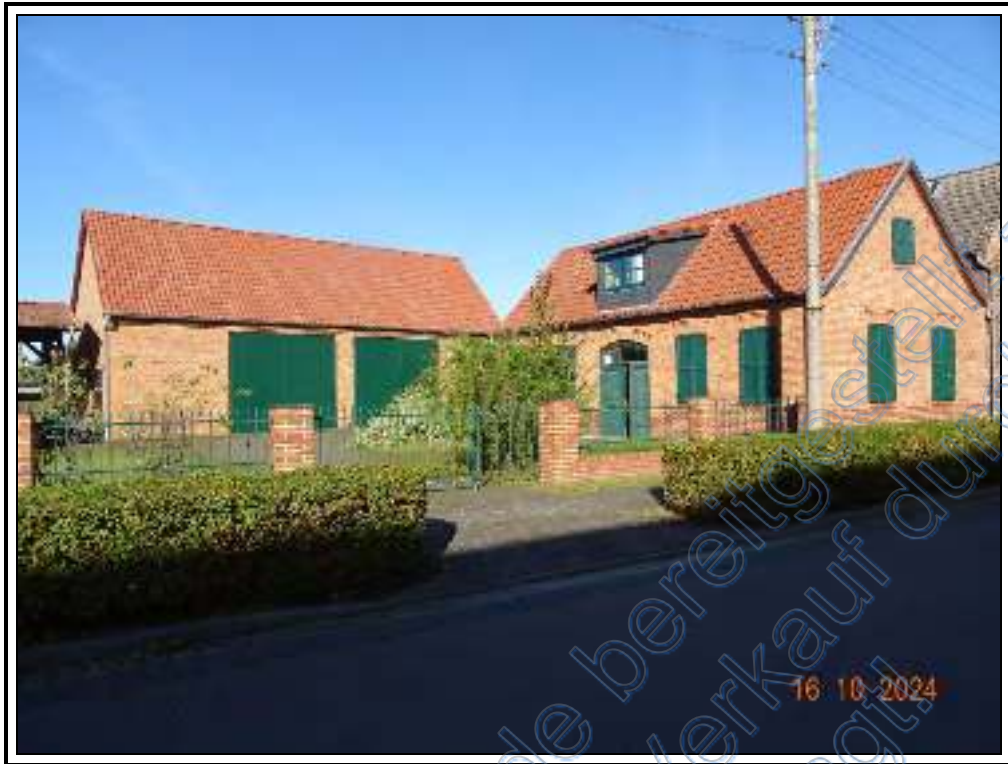
Foto 33: BV Nr. 2 : Grundstücksansicht
