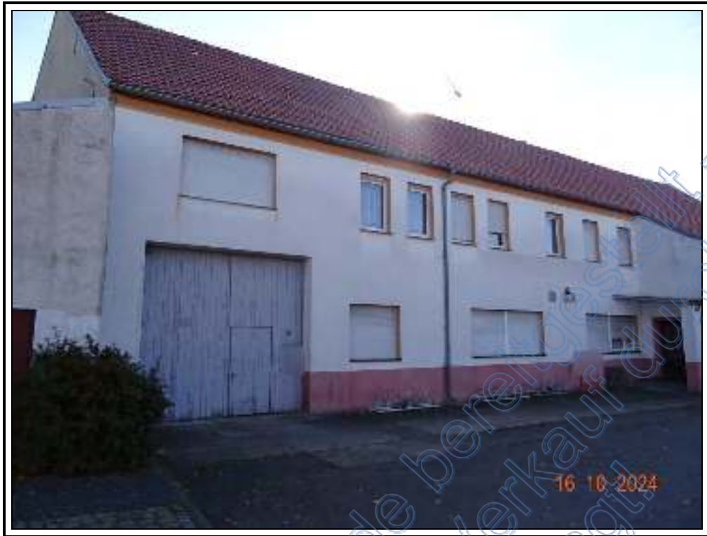
Foto 51: BV Nr. 5 : Grundstücksansicht
