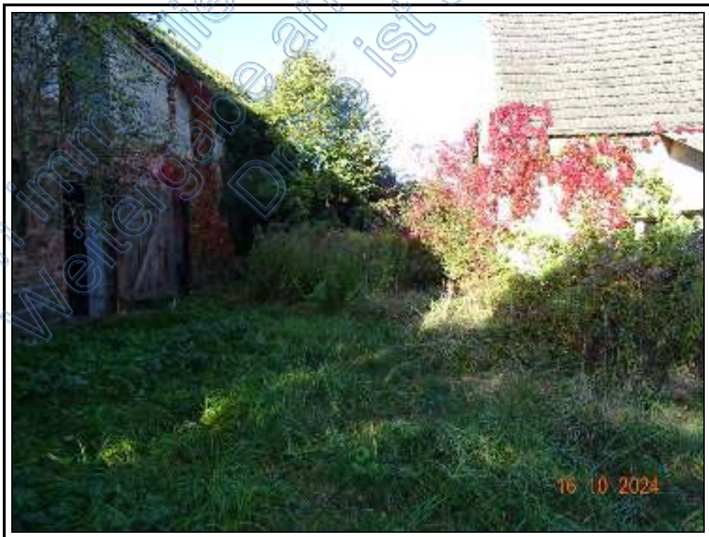
Foto 32: BV Nr. 1 : Grundstücksfreifläche südlich des ehemaligen Wohnhauses
