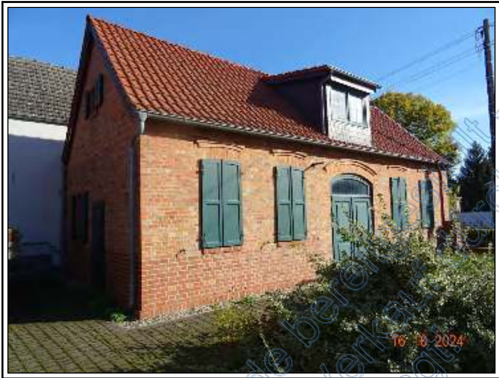
Foto 35: BV Nr. 2 : südwestliche Ansicht des ehemaligen Werkstattgebäudes
