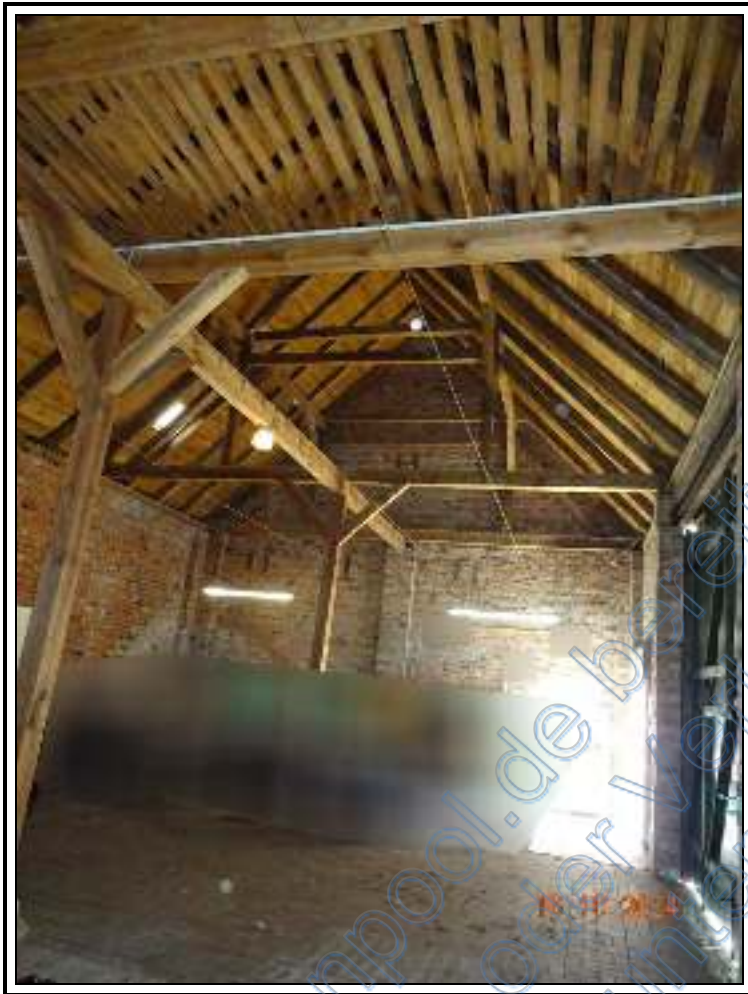
Foto 43: BV Nr. 2 : Abstellraum in der ehemaligen Scheune
