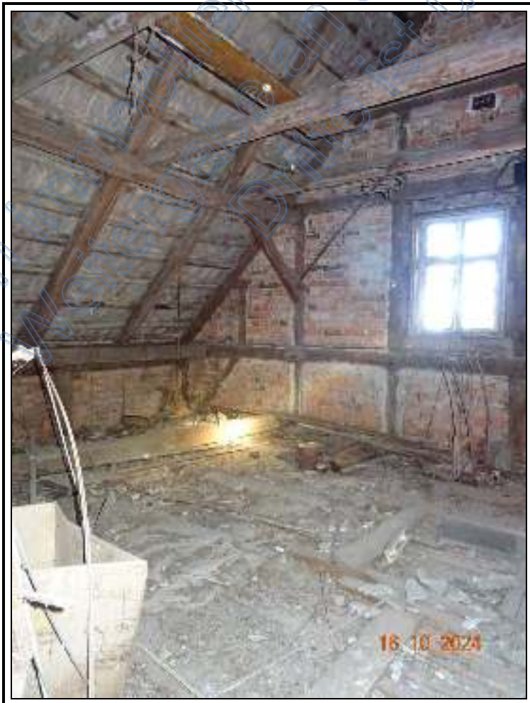
Foto 16: BV Nr. 1 : Dachboden des ehemaligen Wohnhauses
