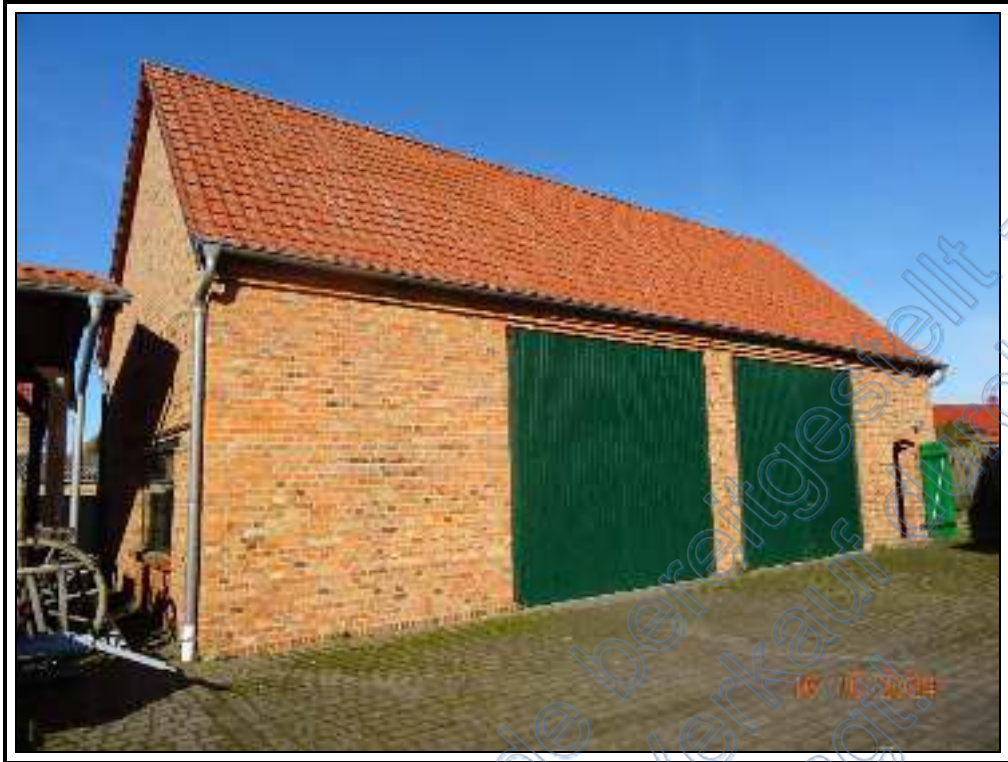
Foto 41: BV Nr. 2 : südöstliche Ansicht der ehemaligen Scheune
