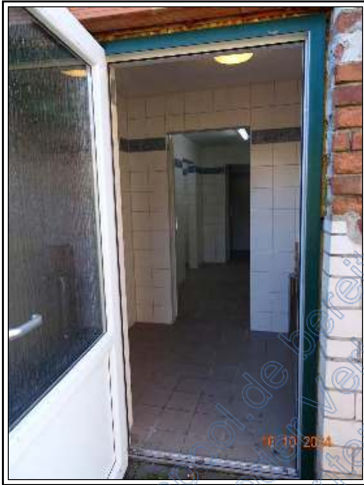
Foto 23: BV Nr. 1 : Windfang im EG des ehemaligen Wirtschaftsgebäudes
