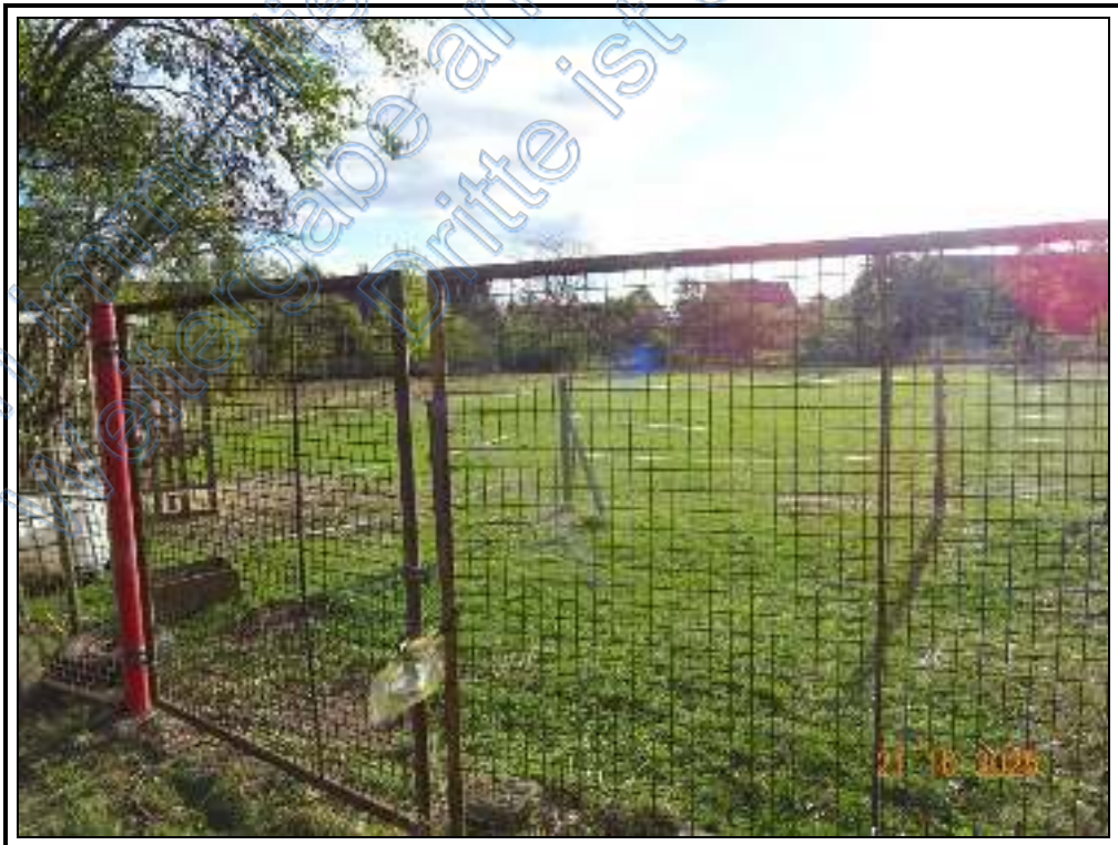
Foto 4: BV Nr. 3 : Übersicht über den östlichen Grundstücksbereich
