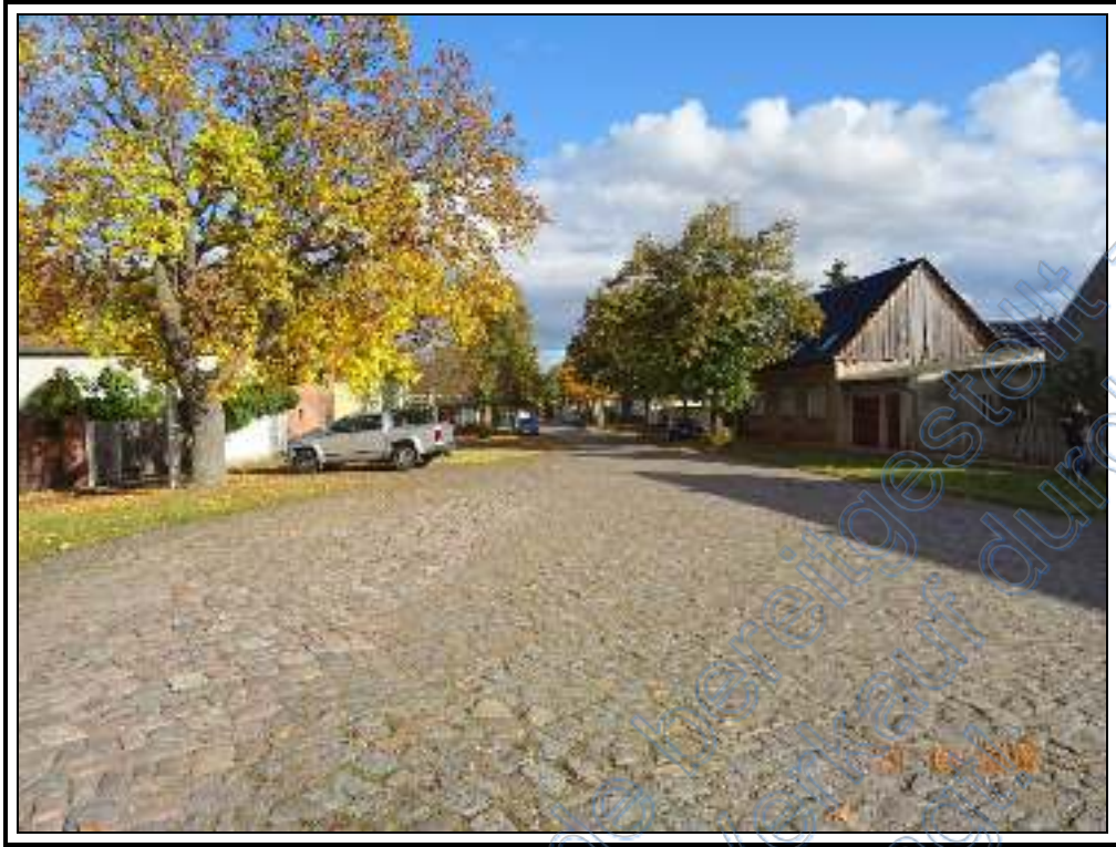
Foto 7: BV Nr. 4 : Anliegerstraße „Merschwitz“, südlich angrenzend
