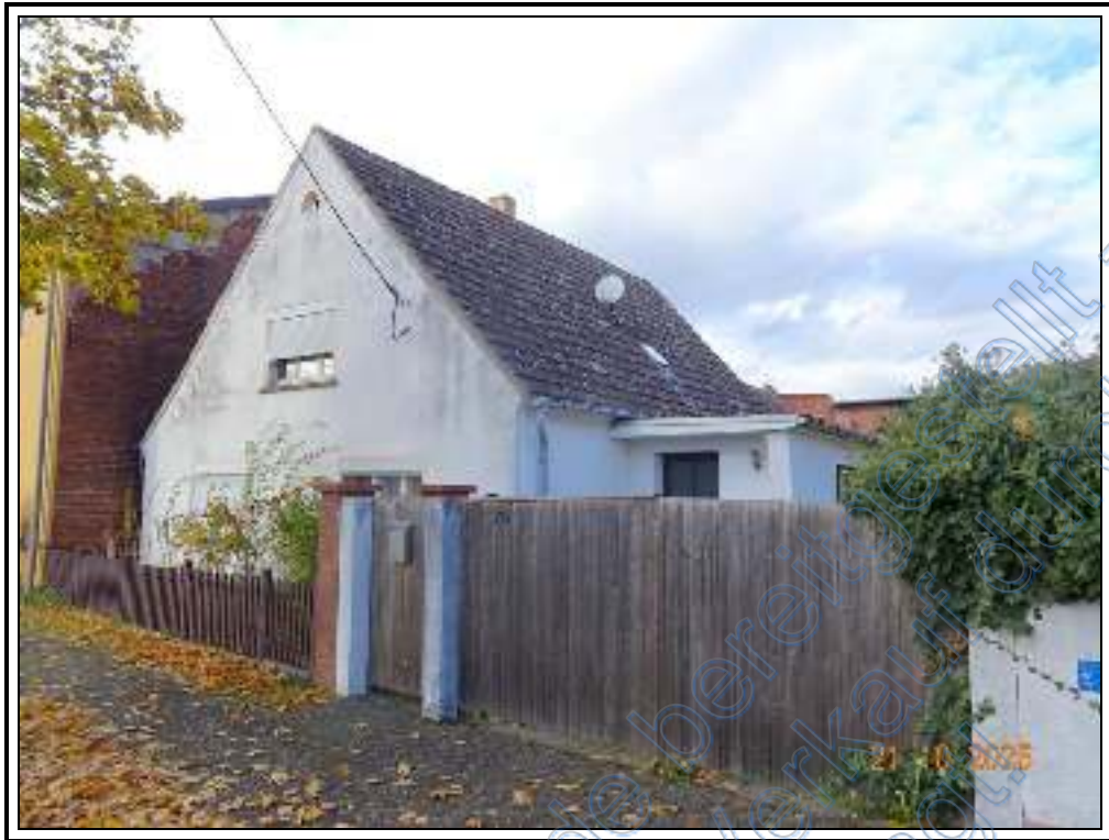
Foto 9: BV Nr. 4 : südöstliche Ansicht des Einfamilienhauses
