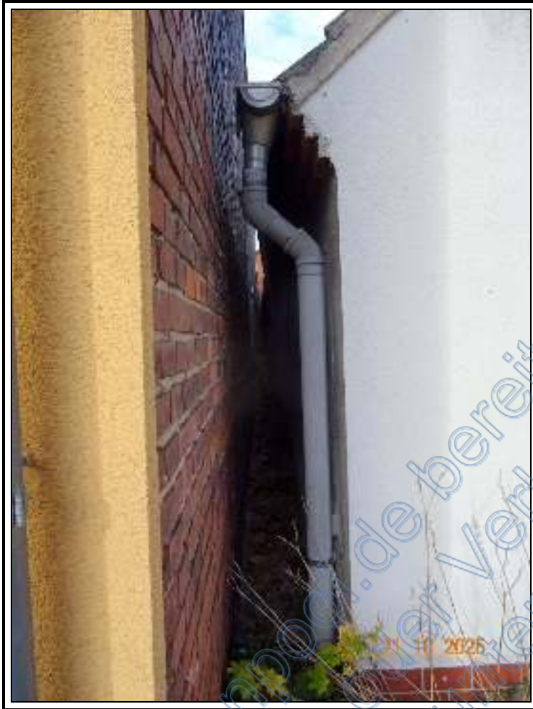
Foto 11: BV Nr. 4: südwestliche Ansicht des Einfamilienhauses
