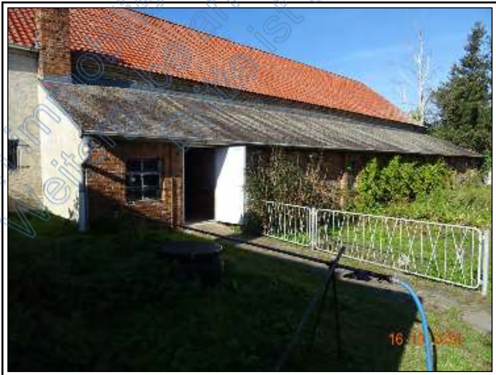
Foto 38: ehemaliges Wirtschaftsgebäude: östliche Ansicht
