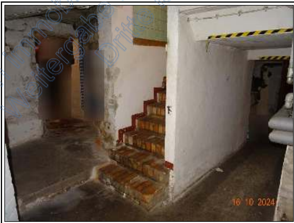
Foto 12: ehemalige Gaststätte: Flure im Gaststättenkeller und Kellertreppe
