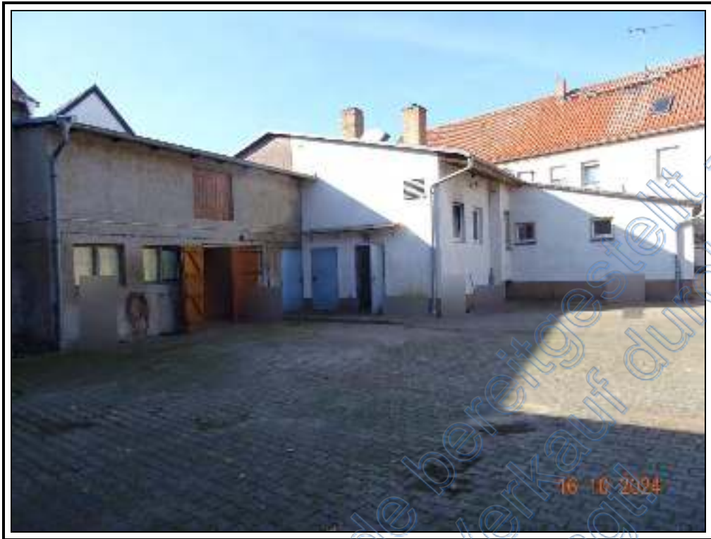
Foto 61: Hof zwischen ehemaliger Gaststätte und ehemaligem Wirtschaftsgebäude
