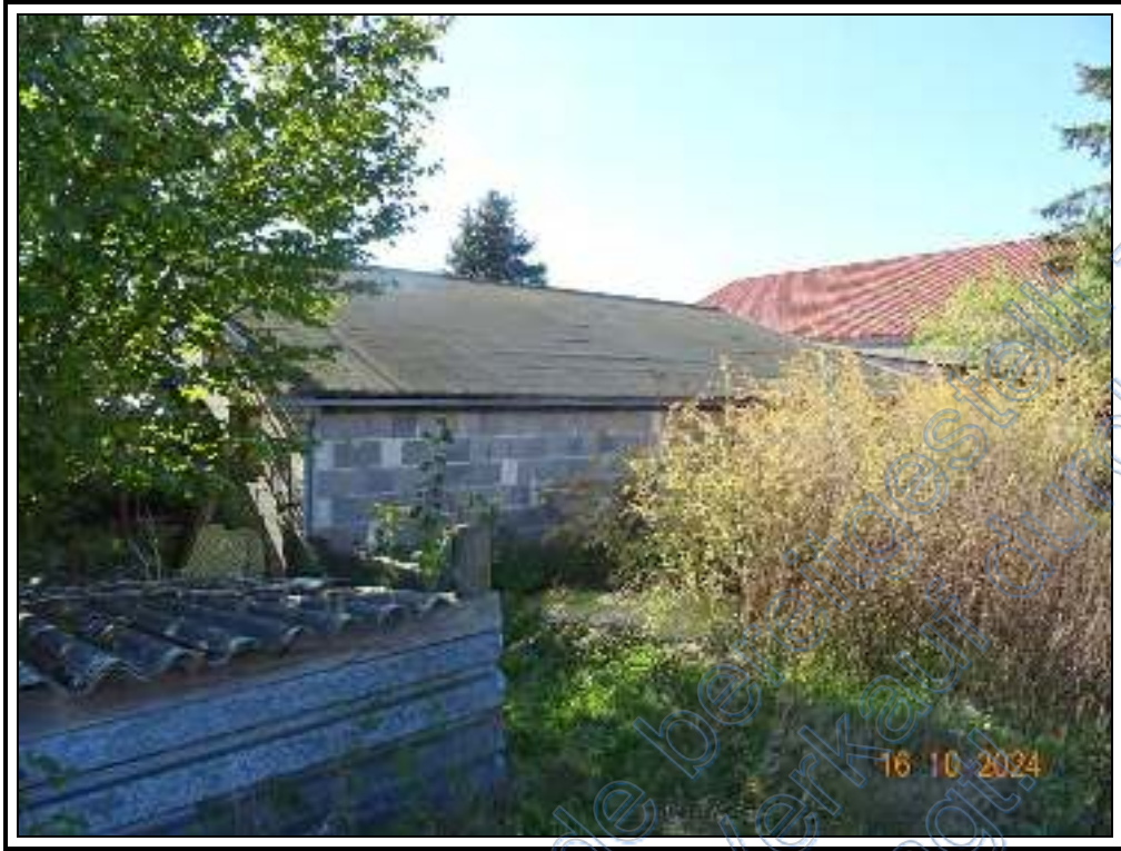
Foto 59: Laube mit Lager: nördliche Ansicht des Lagers
