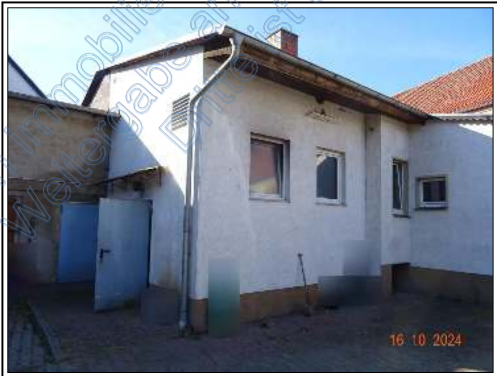
Foto 6: ehemalige Gaststätte: östliche Teilansicht
