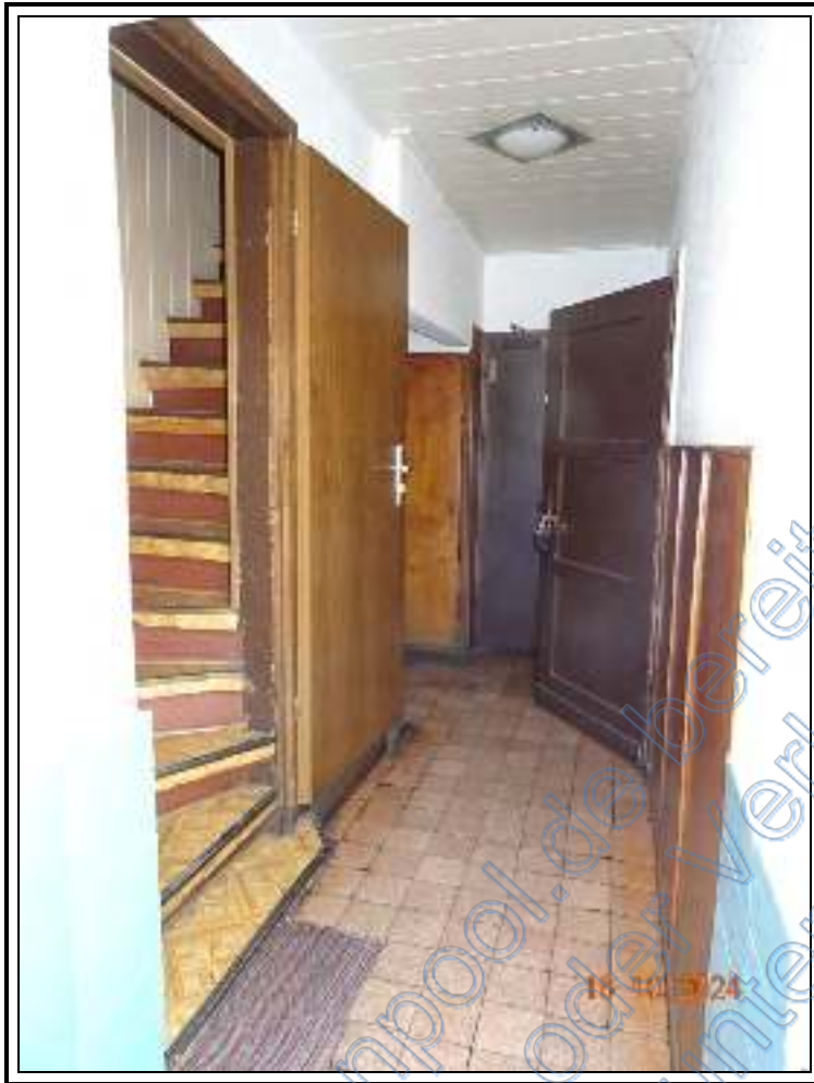
Foto 17: ehemalige Gaststätte: Flur im EG und Geschöß- treppe
