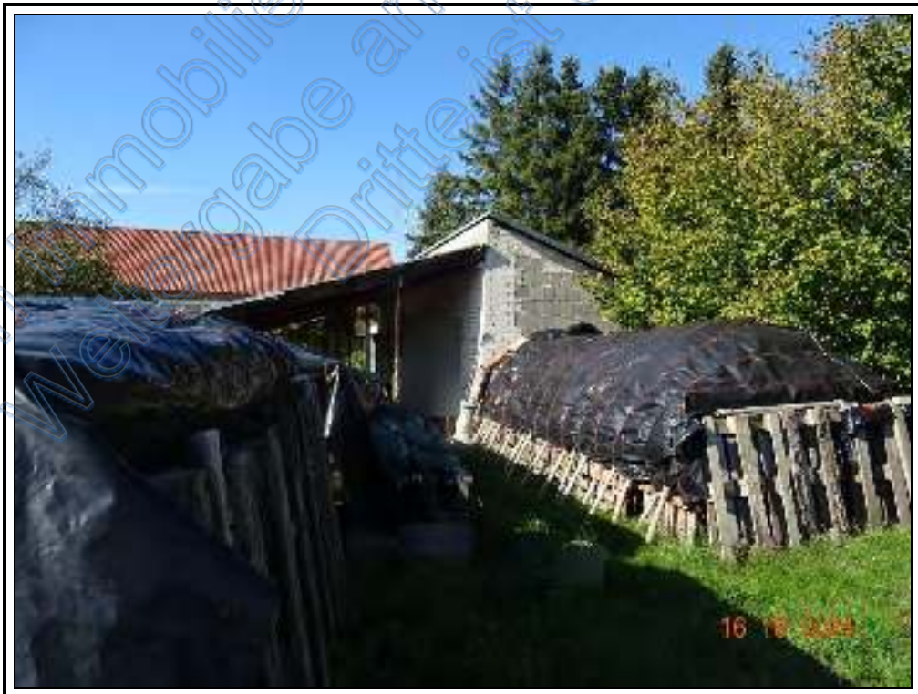
Foto 58: Laube mit Lager: östliche Ansicht des Lagers
