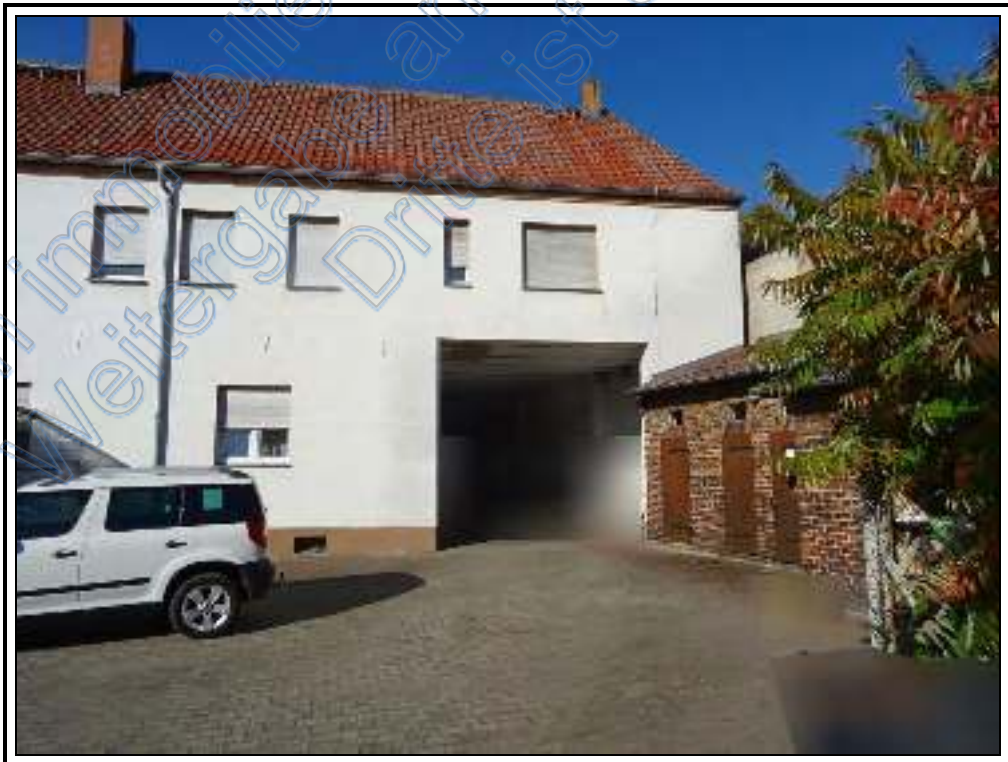
Foto 4: ehemalige Gaststätte: östliche Teilansicht
