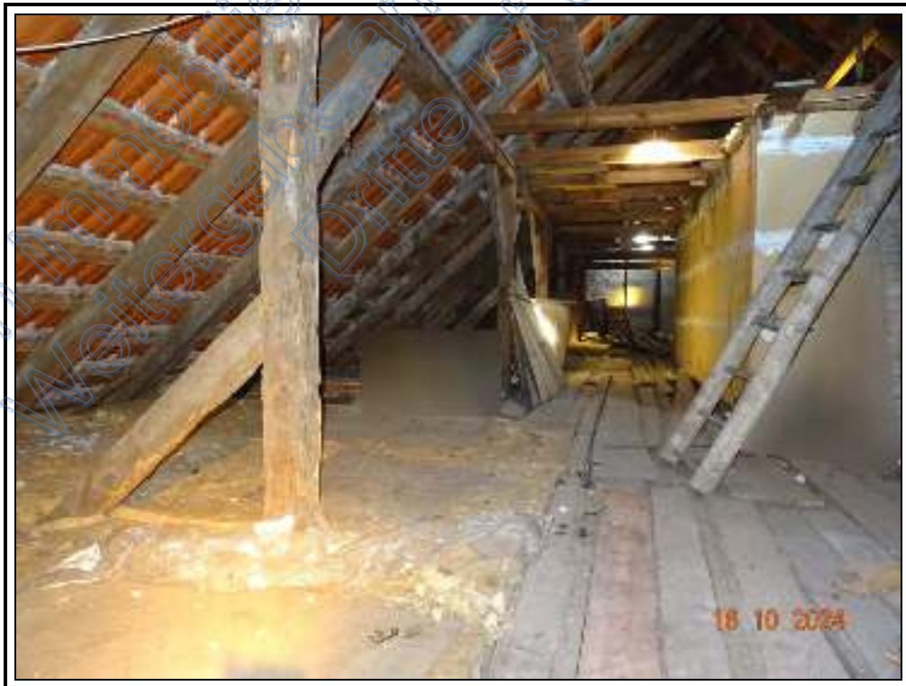
Foto 34: ehemalige Gaststätte: Dachboden im nördlichen DG-Bereich
