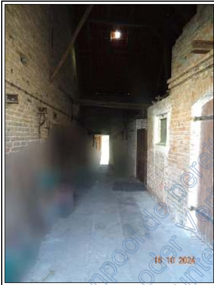
Foto 45: ehemaliges Wirtschaftsgebäude: Durchgang im EG
