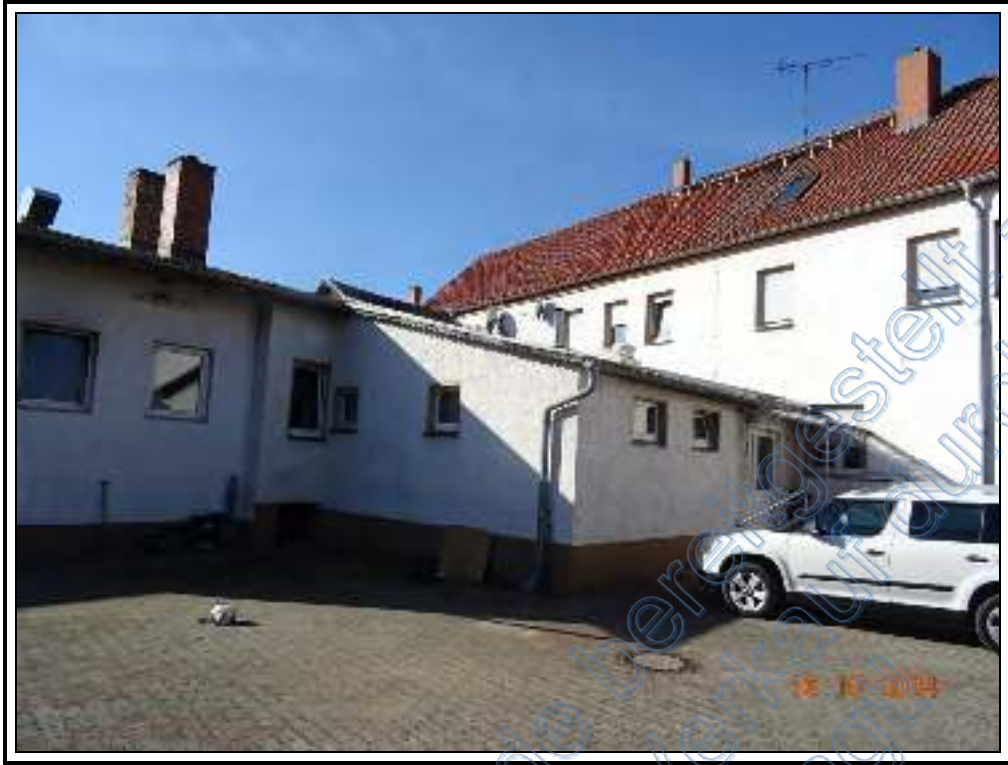
Foto 5: ehemalige Gaststätte: östliche Teilansicht
