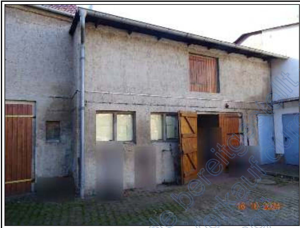
Foto 35: ehemaliges Wirtschaftsgebäude: nördliche Teilansicht
