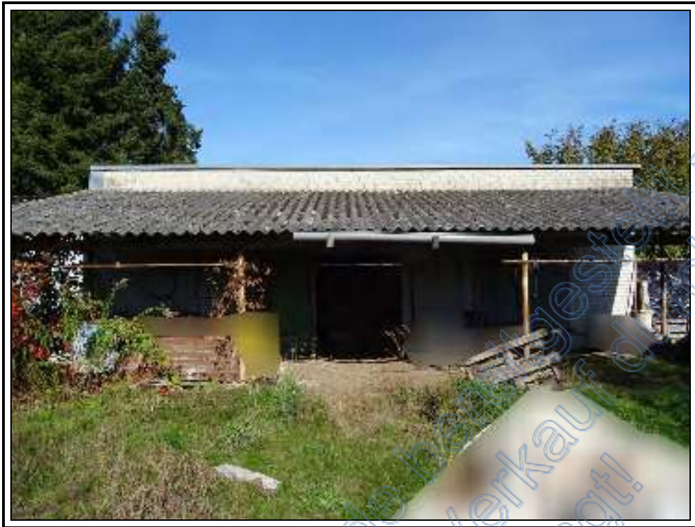
Foto 57: Laube mit Lager: südliche Ansicht des Lagers
