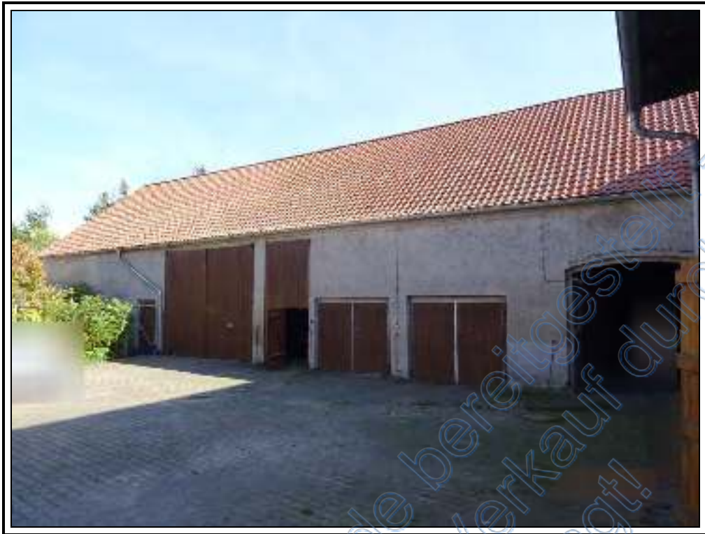
Foto 37: ehemaliges Wirtschaftsgebäude: westliche Teilansicht
