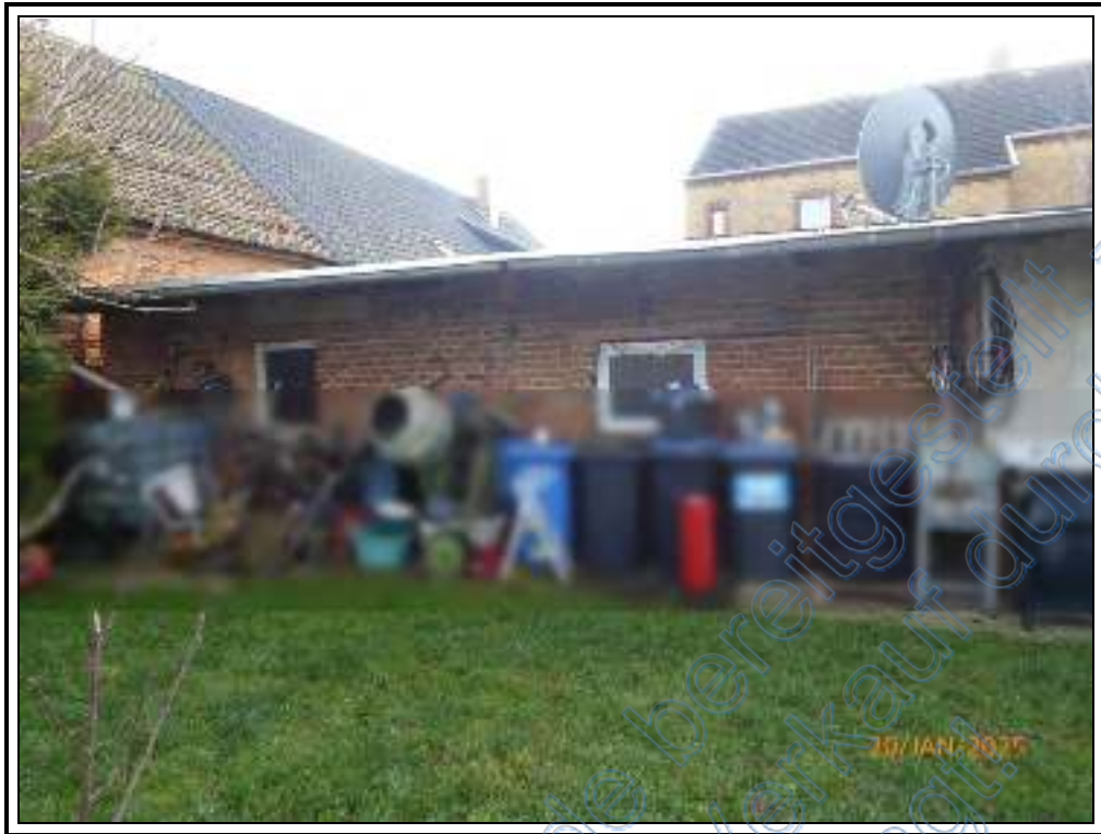
Foto 37: nordwestliche Ansicht des Nebengebäudes
