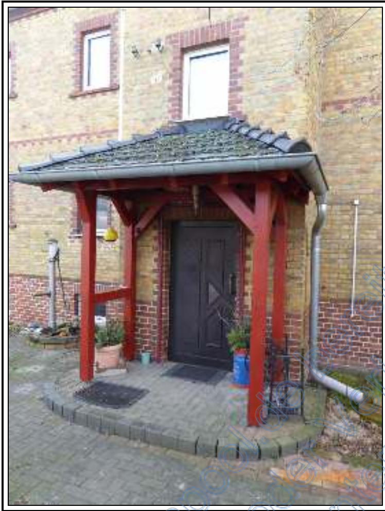
Foto 7: Detailansicht Haus- eingang
