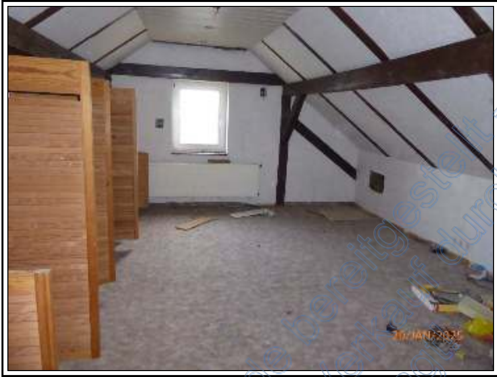
Foto 33: Wohnzimmer im DG des Wohngebäudes
