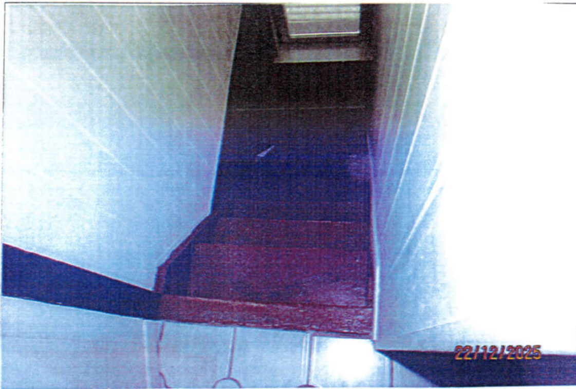
Abbildung 12: Treppe vom Bad im Dachgeschoss zum Obergeschoss.
