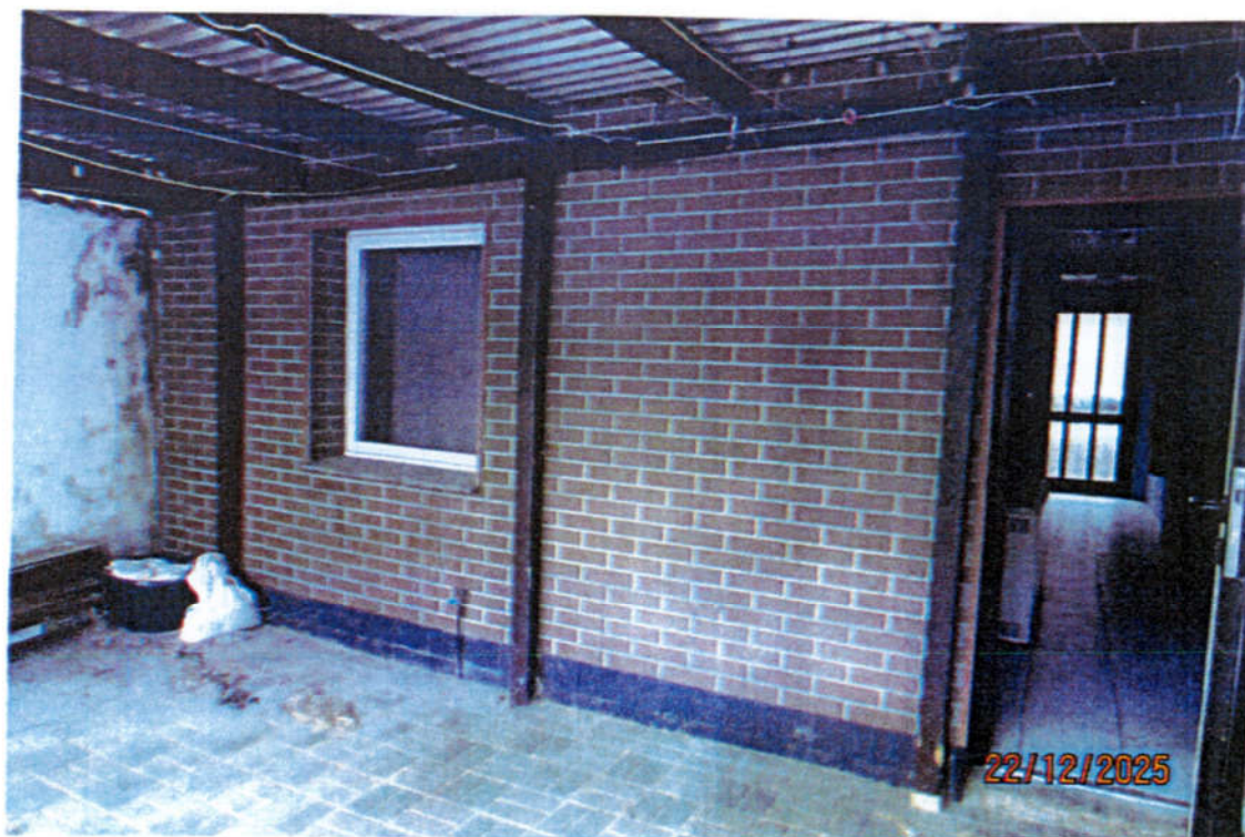
Abbildung 23: Nahaufnahme mit Zugang zum Durchgangsflur bezogen auf obiges Foto.
