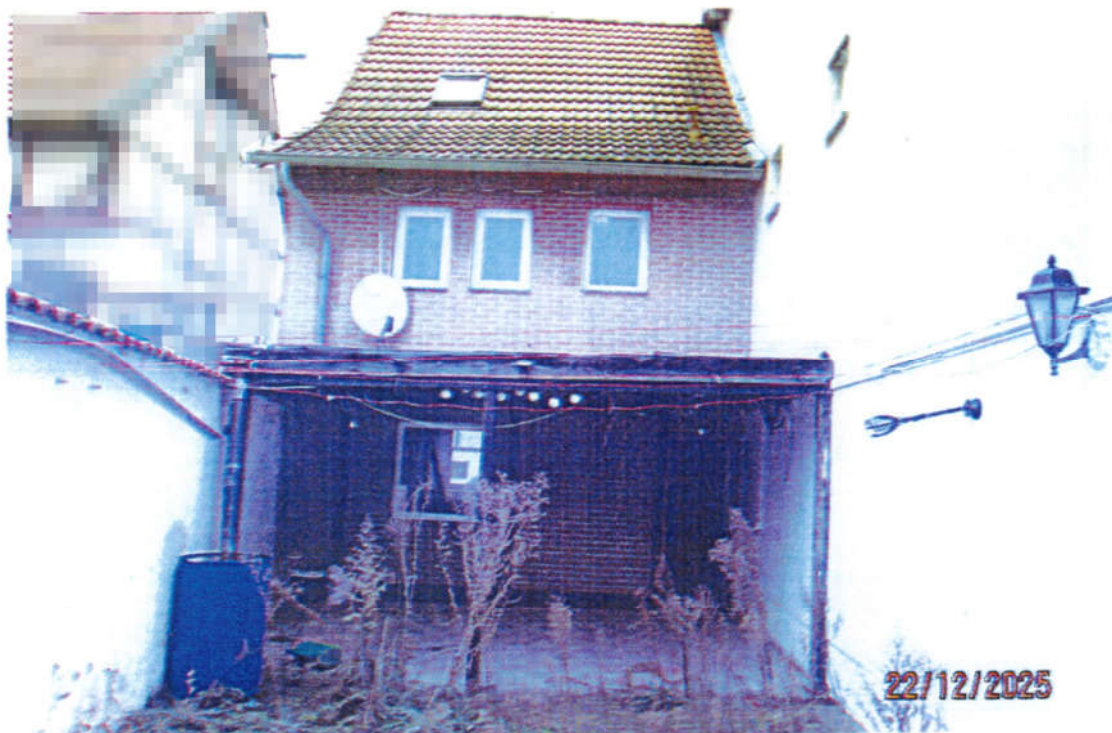
Abbildung 22: Innenhof mit überdachter Sitzecke.
