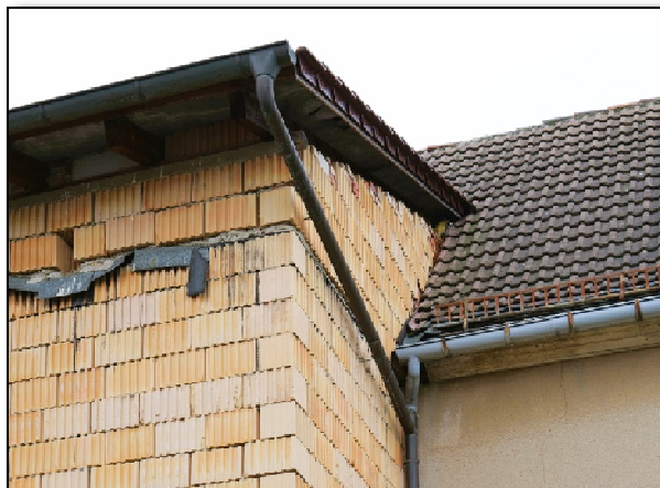
BILD 6: MFH Detail nachträglicher Anbau
