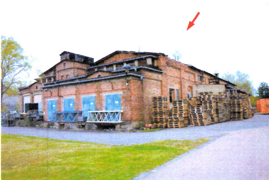
Foto 2 Südwestansicht des BWO 2, Gebäude 1 (roter Pfeil)
