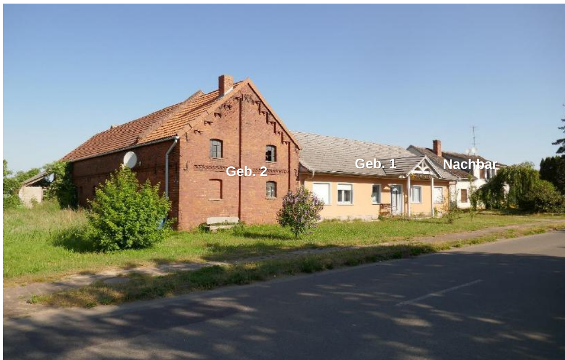
Foto 2, Straßenansicht Grundstück mit Einfamilienhaus (Geb. 1) und ehemaligem Stallgebäude mit Scheunenteil (Geb. 2), Südostansicht
