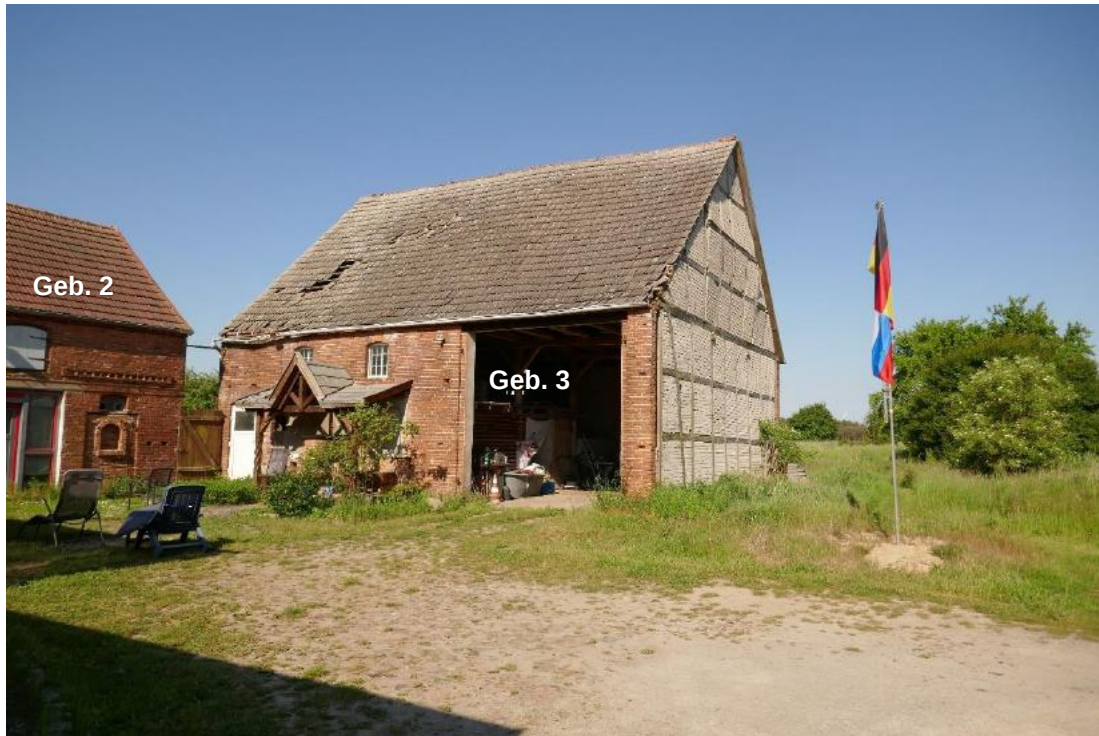
Foto 7, Hofansicht ehemalige Scheune (Geb. 3) und ehemaliges Stallgebäude mit Scheunenteil (Geb. 2), Nordostansicht
