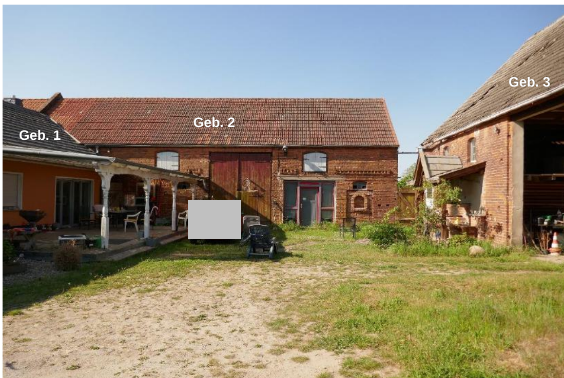
Foto 6, Hofansicht Einfamilienhaus (Geb. 1) mit überdachter Terrasse, überdachtem Freisitz, im Hintergrund ehemaliges Stallgebäude mit Scheunenteil (Geb. 2), rechts ehemalige Scheune (Geb. 3), Nordostansicht
