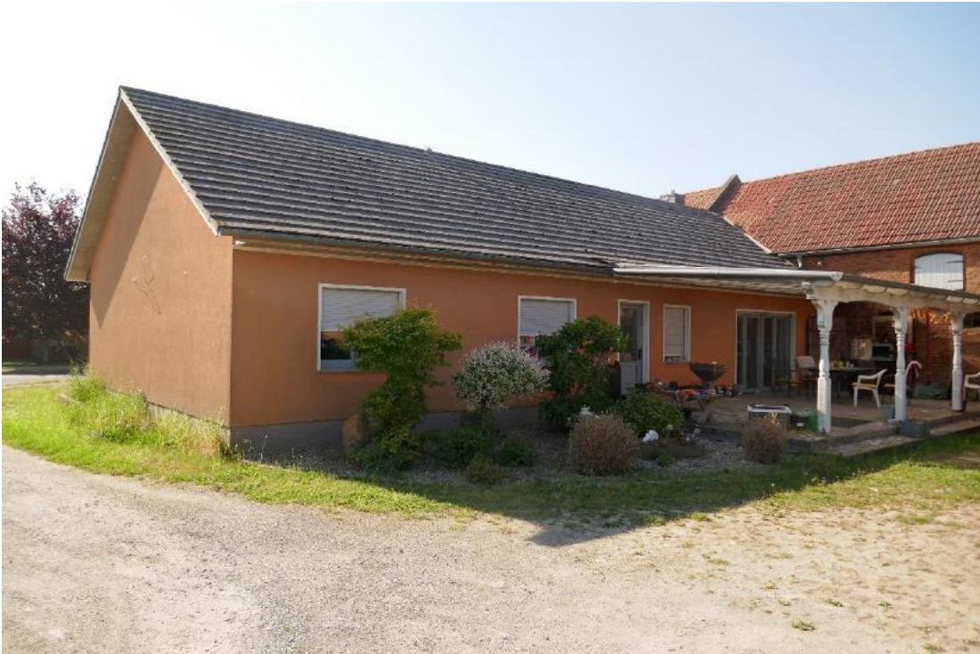
Foto 5, Hofansicht Einfamilienhaus (Geb. 1) mit überdachter Terrasse, überdachtem Freisitz, im Hintergrund ehemaliges Stallgebäude mit Scheunenteil (Geb. 2), Nordwestansicht
