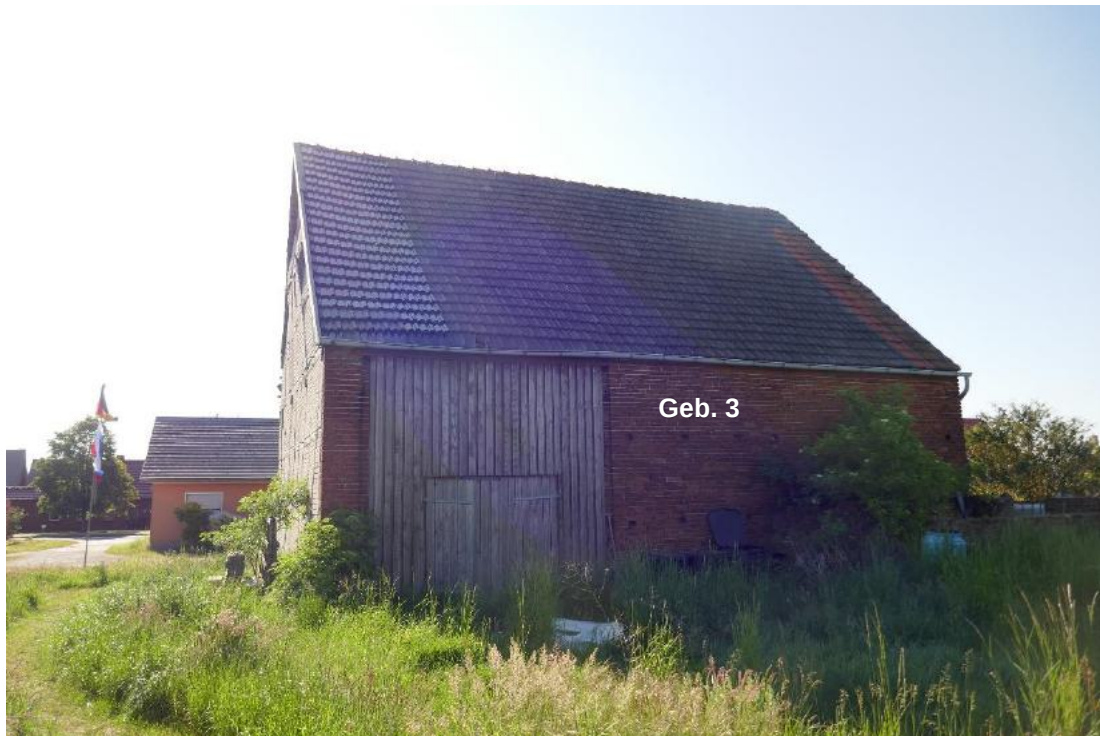
Foto 9, Rückseite ehemalige Scheune (Geb. 3), Westansicht
