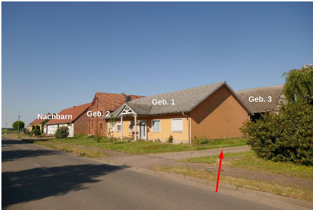
Foto 3, Straßenansicht Grundstück mit Einfamilienhaus (Geb. 1), ehemaligen Stallgebäude mit Scheunenteil (Geb. 2) und ehemaliger Scheune (Geb. 3), Pfeil weist zur Grundstückszufahrt, Nordostansicht
