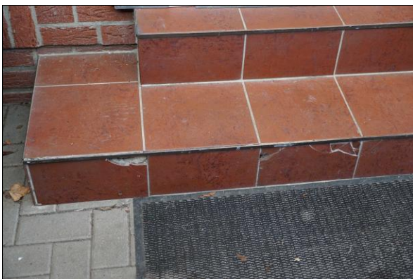
Schäden an der Seiteneingangstreppe
