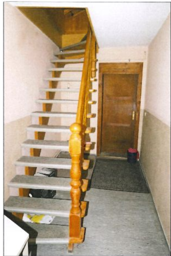
Gebäuedurchgang mit Geschosstreppe
