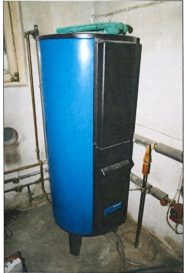
Warmwasserspeicher
