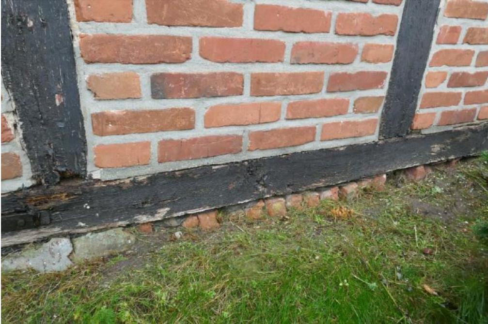
**Foto 13, Wohn-/Einfamilienhaus (Geb. 1), straßenseitige Außenwand, geschädigte Fußschwelle und geschädigter Pfosten des Fachwerks, Westansicht**
