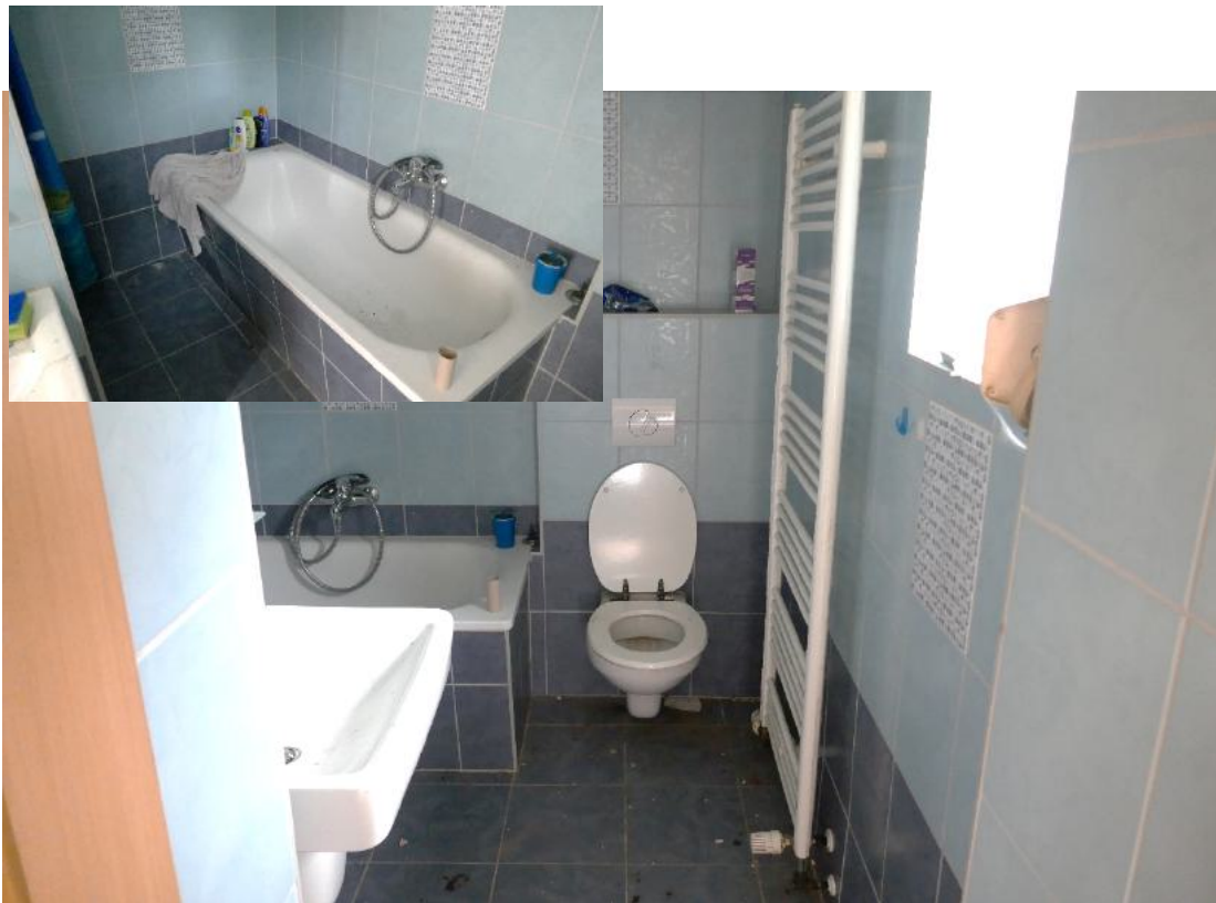
Foto 15, EG Bad/WC, kleines Foto eingebaute, eingeflieste Wanne
