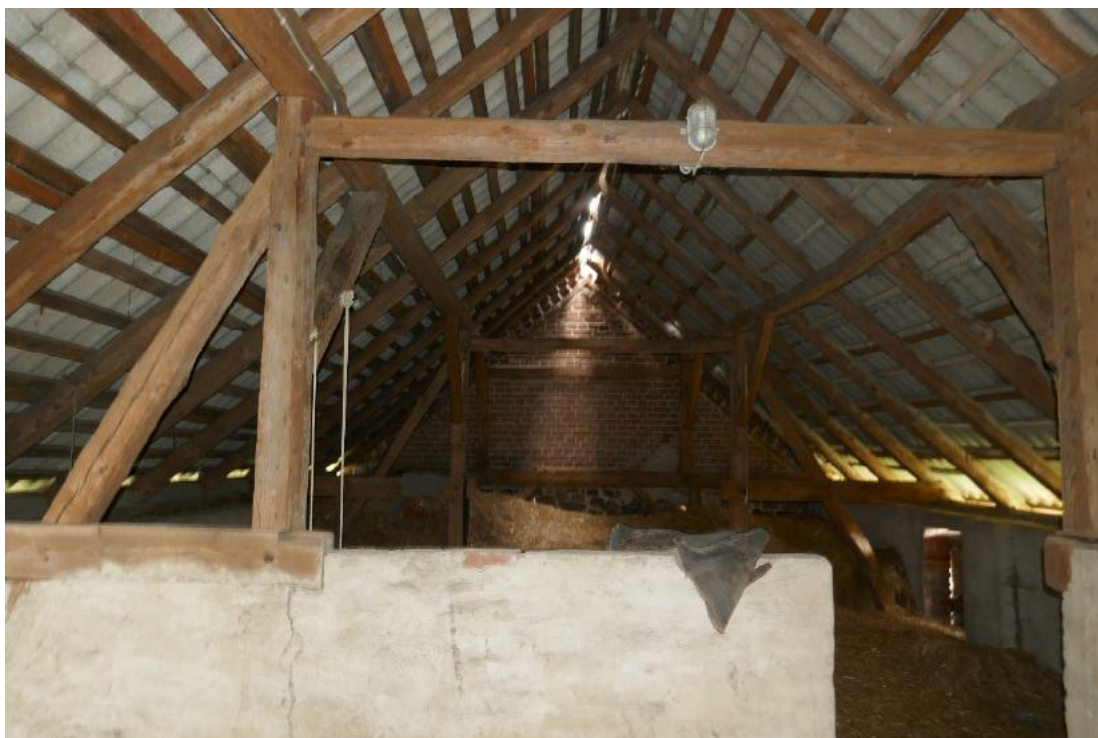
Foto 23, Dachgeschoss (DG) Dachraum mit hohem Drenpel/Kniestock
