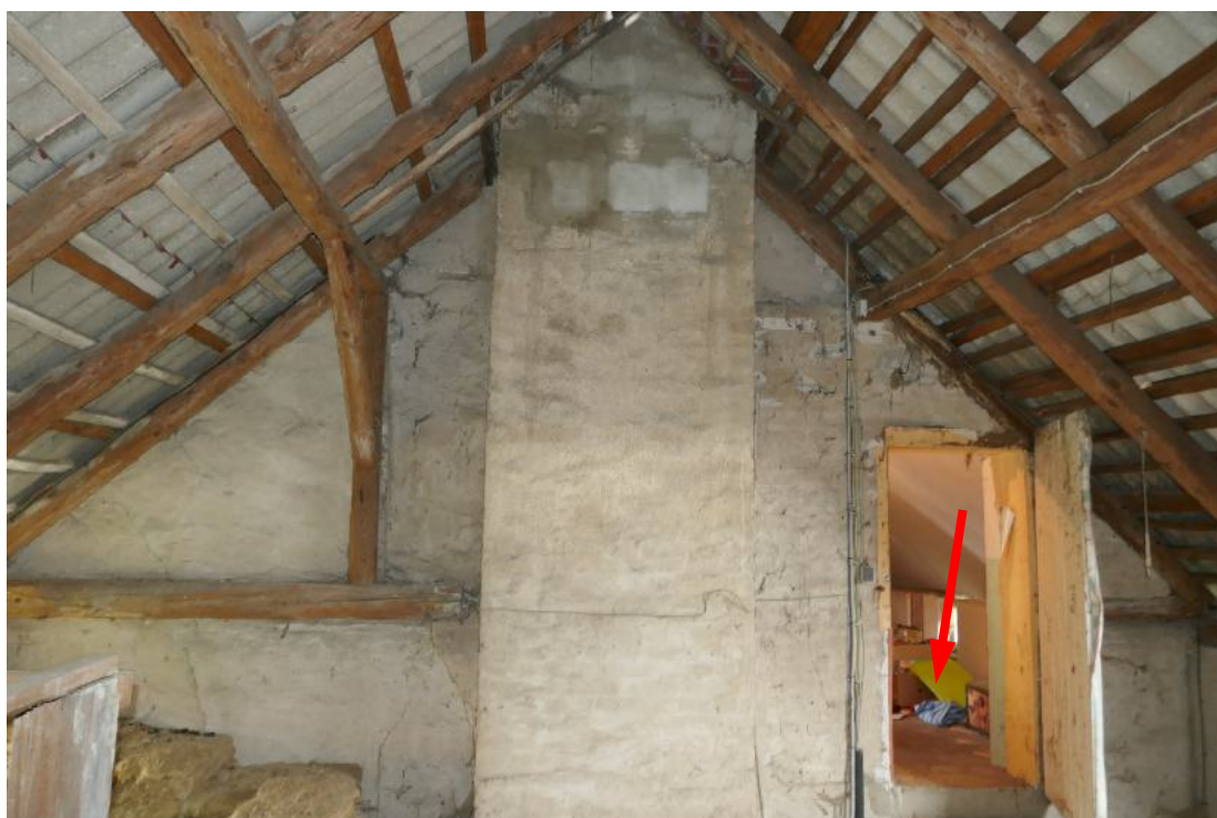
Foto 24, DG Blick vom Dachraum zum Flur im Dachgeschoss Wohngebäude (Pfeil)
