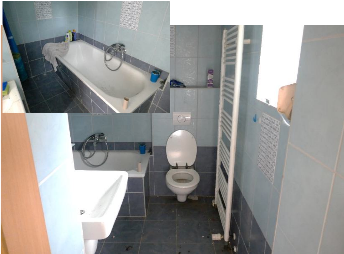
Foto 15, EG Bad/WC, kleines Foto eingebaute, eingeflieste Wanne
