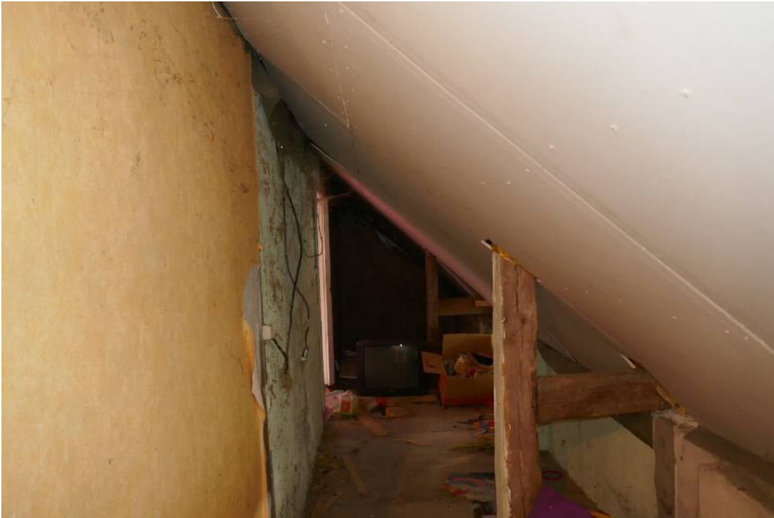
Foto 21, DG eine Abseite, Ausbau noch nicht abgeschlossen
