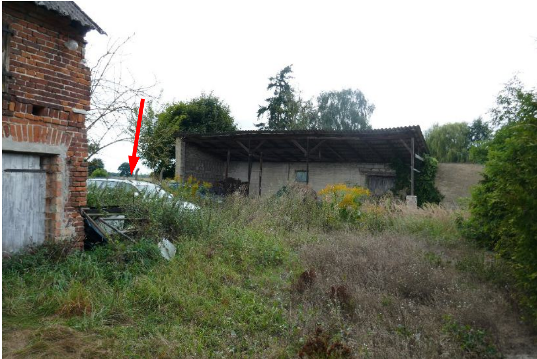
Foto 9, Blick zum Unterstand (Geb. 2), Pfeil weist zu einem fahruntüchtigen Pkw, Südostansicht
