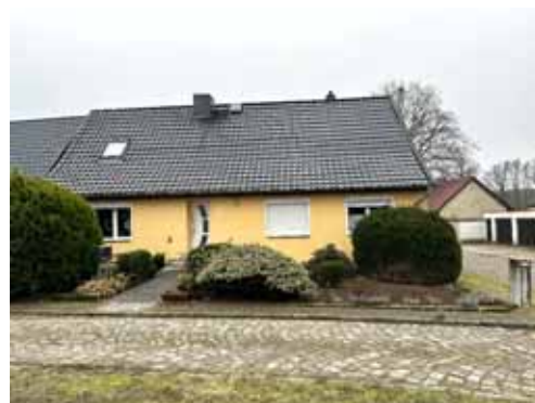
Straßenansicht EFH, Flurstück 310
