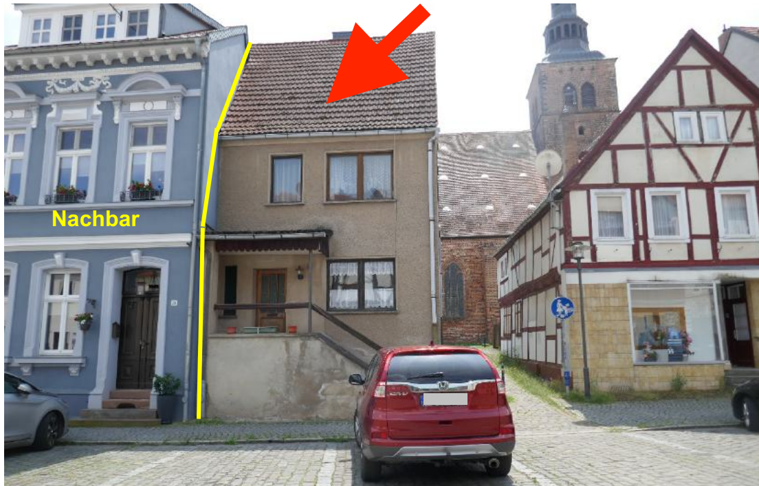
Foto 1, Blick von der Straße Am Aschberg zum Grundstück mit Reihenendhaus (Geb. 1), Nordsicht
