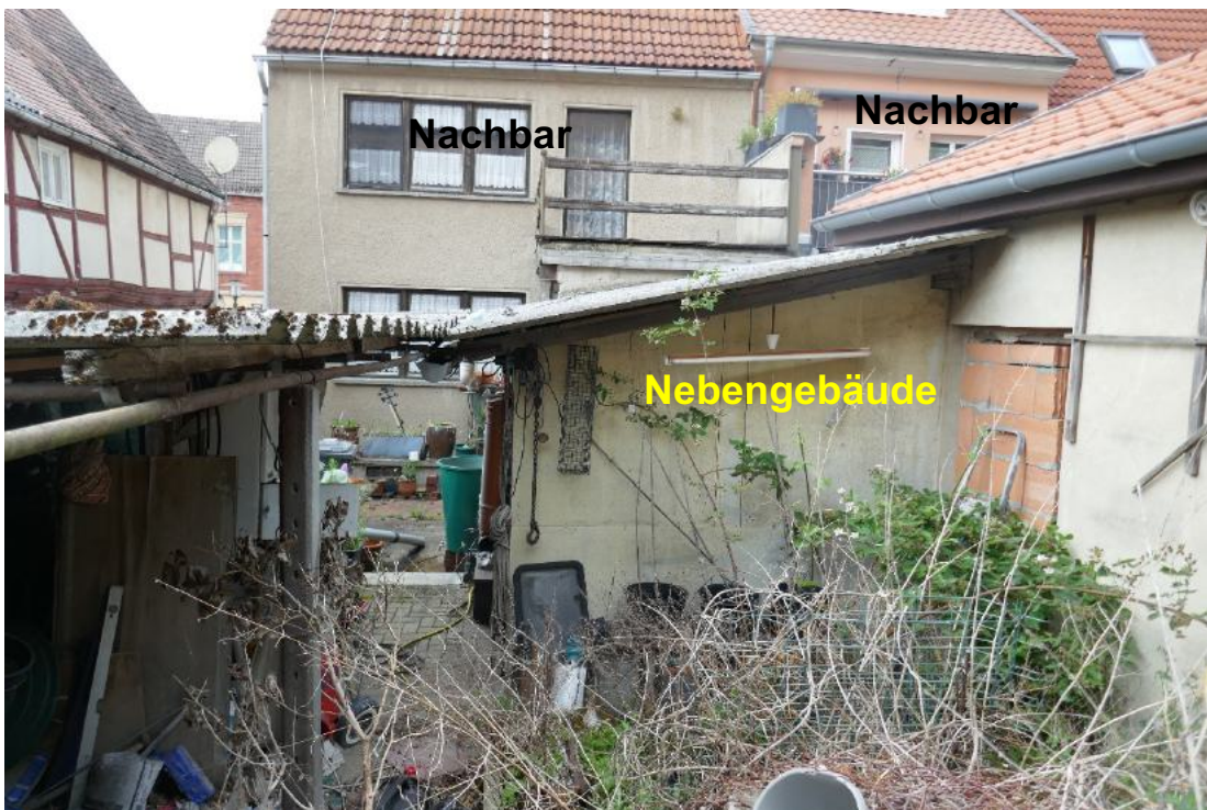
Foto 6, Blick vom Marienkirchplatz über die Mauer der Einfriedung in den Hof mit Nebengebäude (Geb. 2), Südostansicht
