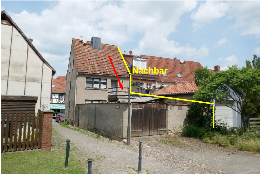
Foto 5, Blick vom Marienkirchplatz zum Grundstück, Pfeil weist zum Balkon/Terrasse über der Kelleraußentreppe, Südwestansicht
