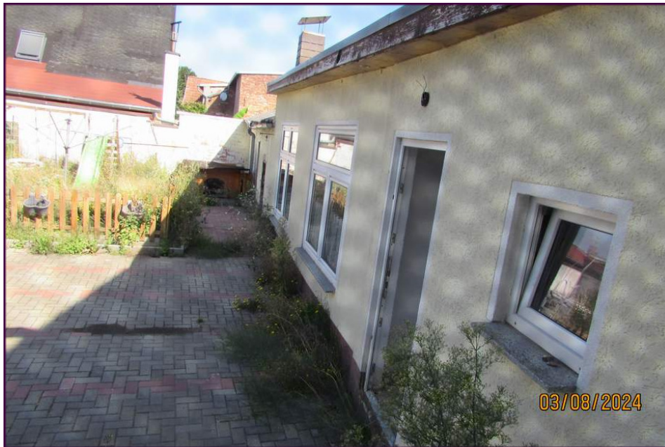
Abbildung 3: Gebäudeansicht B und C.
