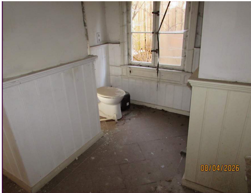
Abbildung 5: Blick in die Toilette.
