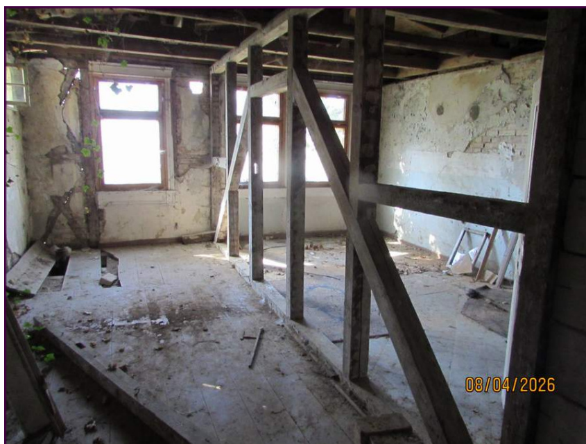
Abbildung 6: Wohnraum im südl. Gebäudeanbau.
