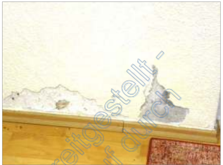
Feuchtigkeitsschäden im Anbau Nr. 1.2
