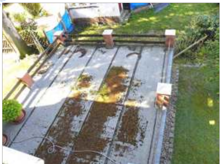
mangelhafter Zustand des Terrassenaufbaus
