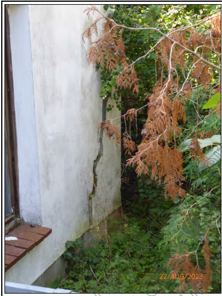
Foto 49: Detailansicht: Beispiel für Risse in den Außenwänden im Bereich der westlichen Gebäudeecke bzw. „Werkstatt“
