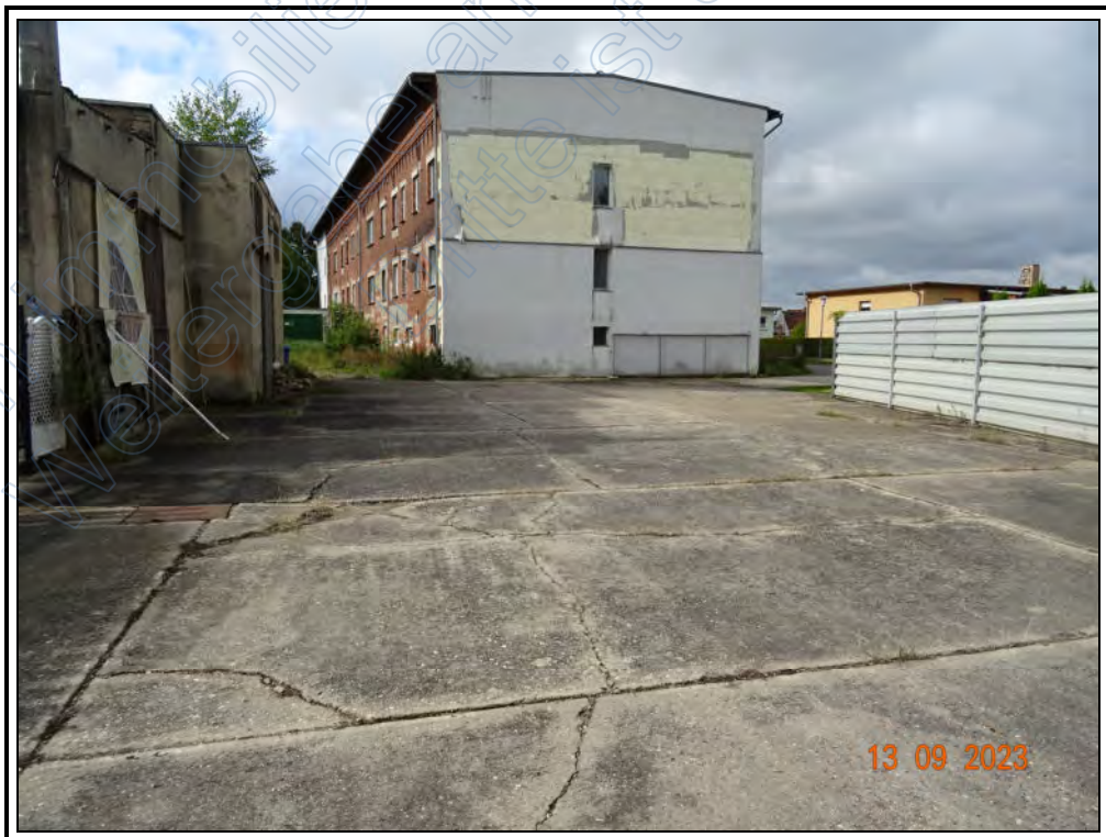
Foto 36: Freifläche/ Hof im nordwestlichen Grundstücksbereich
