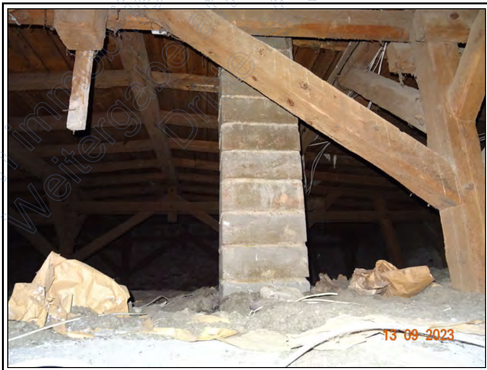
Foto 18: Spitzboden des Mehrfamiliendoppelhauses
