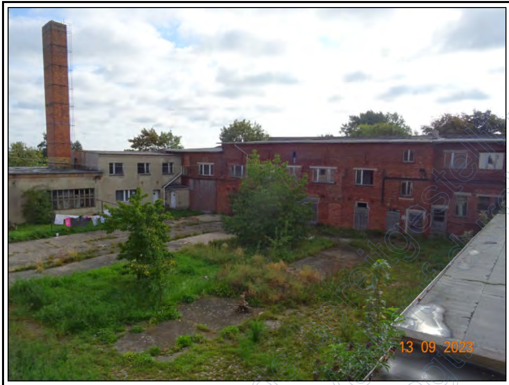
Foto 31: östliche Teilansicht des Wirtschaftsgebäudes
