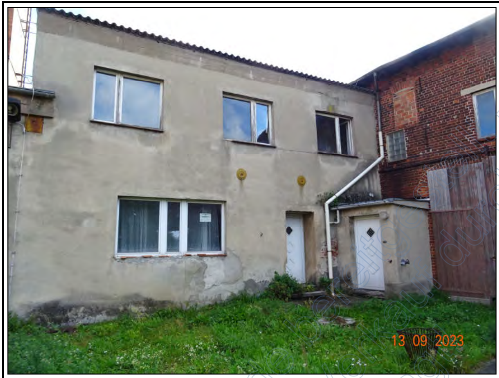
Foto 33: südliche Teilansicht des Heizhauses/ Verwaltungsgebäudes
