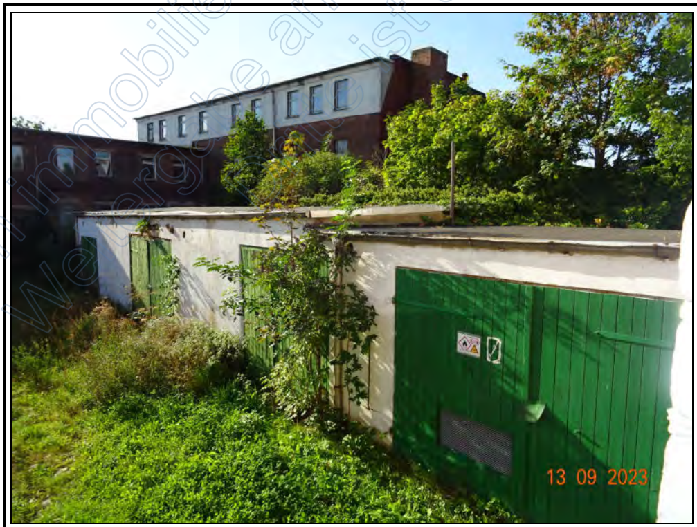
Foto 24: nordwestliche Ansicht der Garagen
