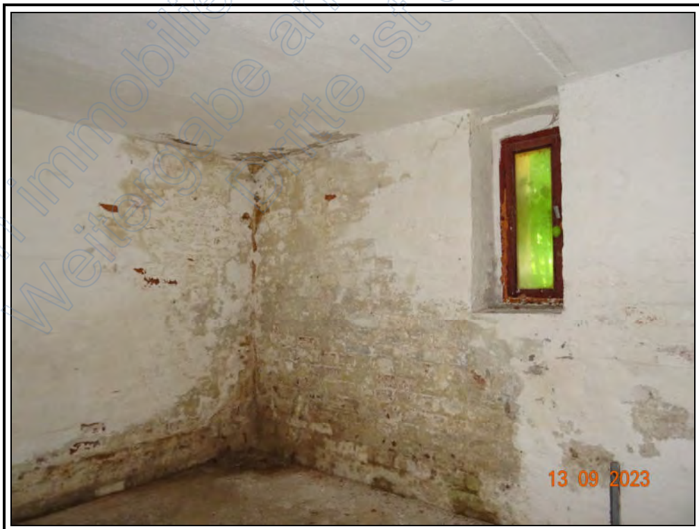
Foto 14: beispielhafter Abstellraum im KG des Mehrfamiliendoppelhauses
