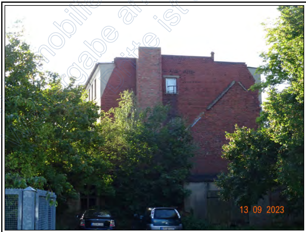
Foto 26: westliche Ansicht des Torhauses
