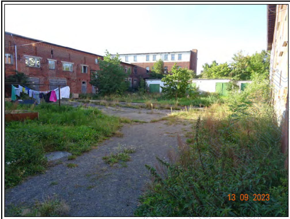
Foto 37: Freifläche/ Hof im zentralen Grundstücksbereich, Blickrichtung Süd
