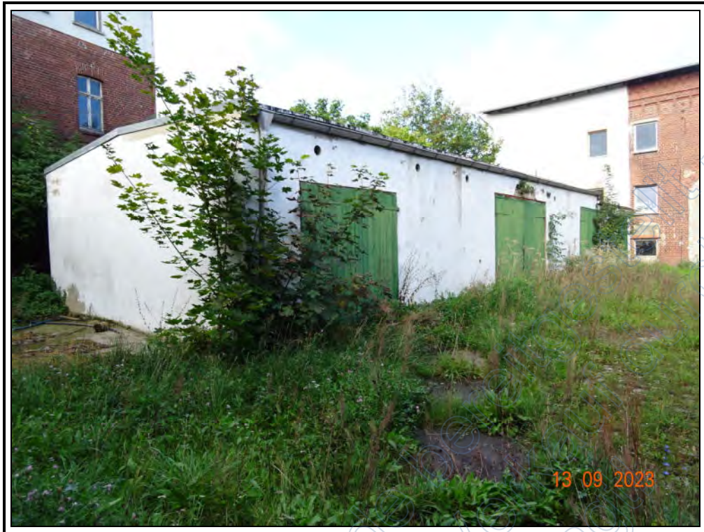
Foto 23: nordöstliche Ansicht der Garagen
