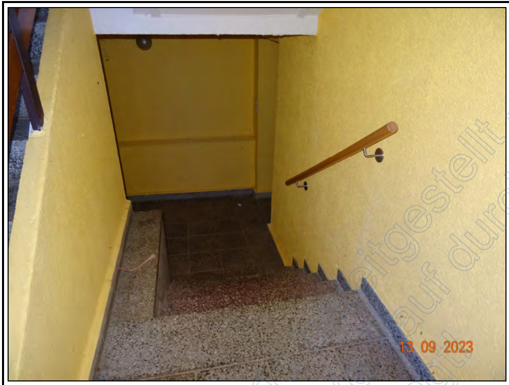
Foto 15: Treppenhaus im KG des Mehrfamiliendoppelhauses
