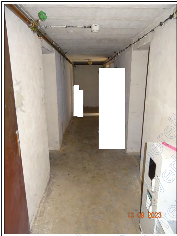
Foto 11: beispielhafter Flur im KG des Mehrfamiliendoppel- hauses
