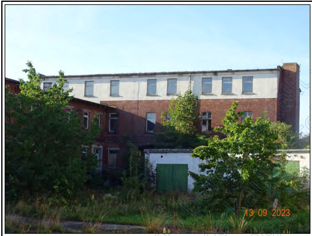
Foto 27: nördliche Ansicht des Torhauses
