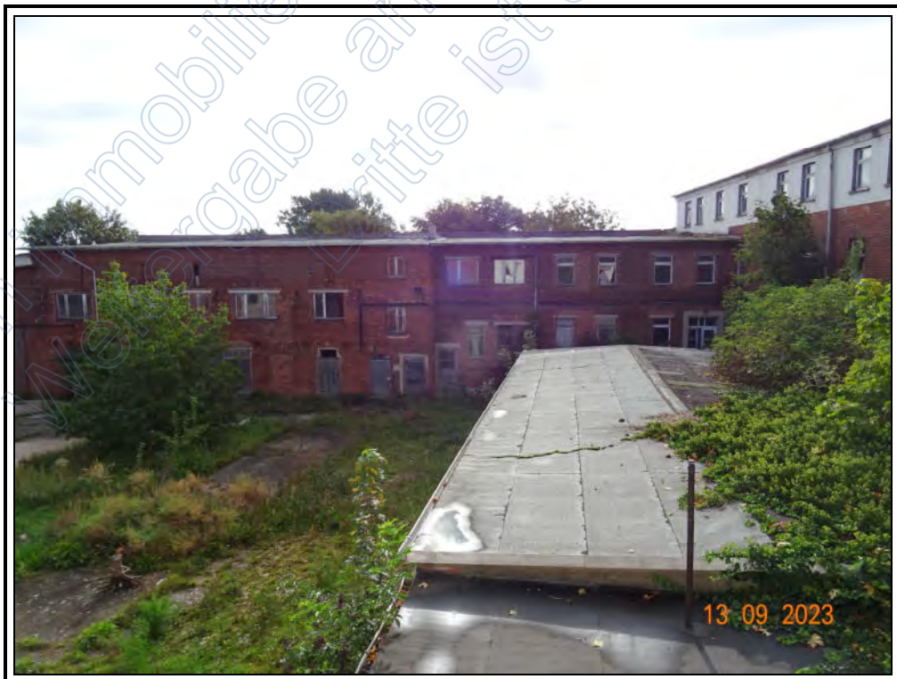
Foto 32: östliche Teilansicht des Wirtschaftsgebäudes
