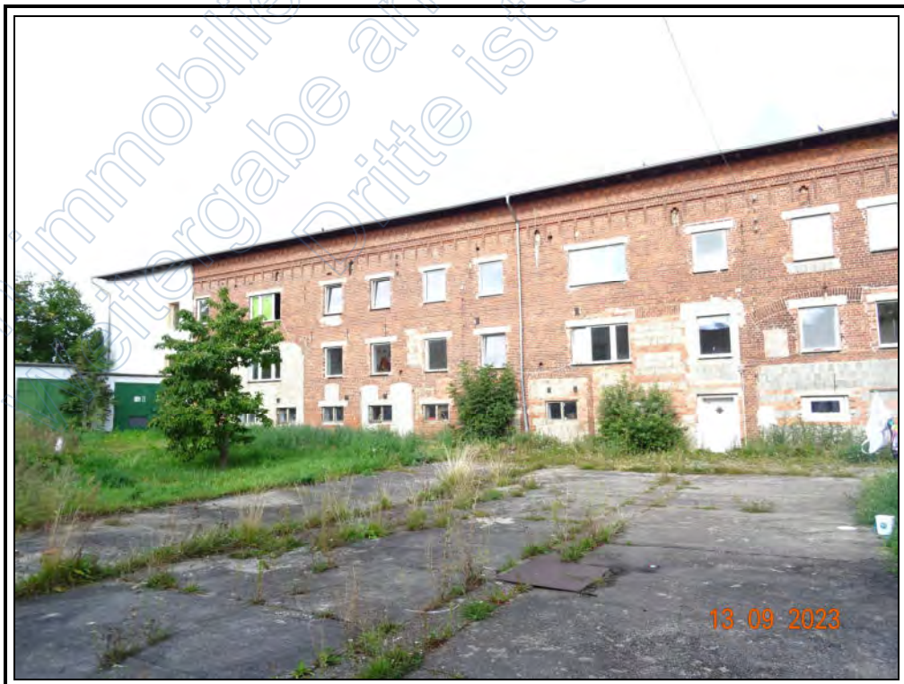
Foto 8: östliche Ansicht des Mehrfamiliendoppelhauses
