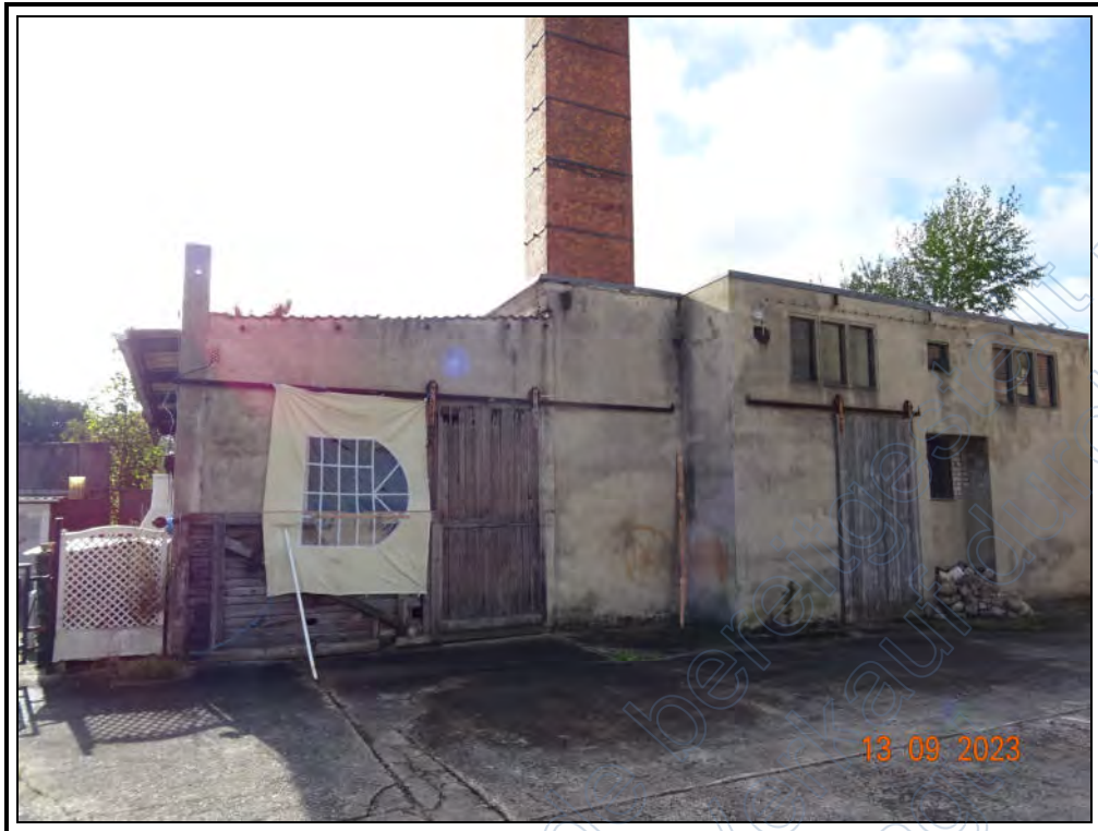
Foto 35: westliche Ansicht des Heizhauses/ Verwaltungsgebäudes
