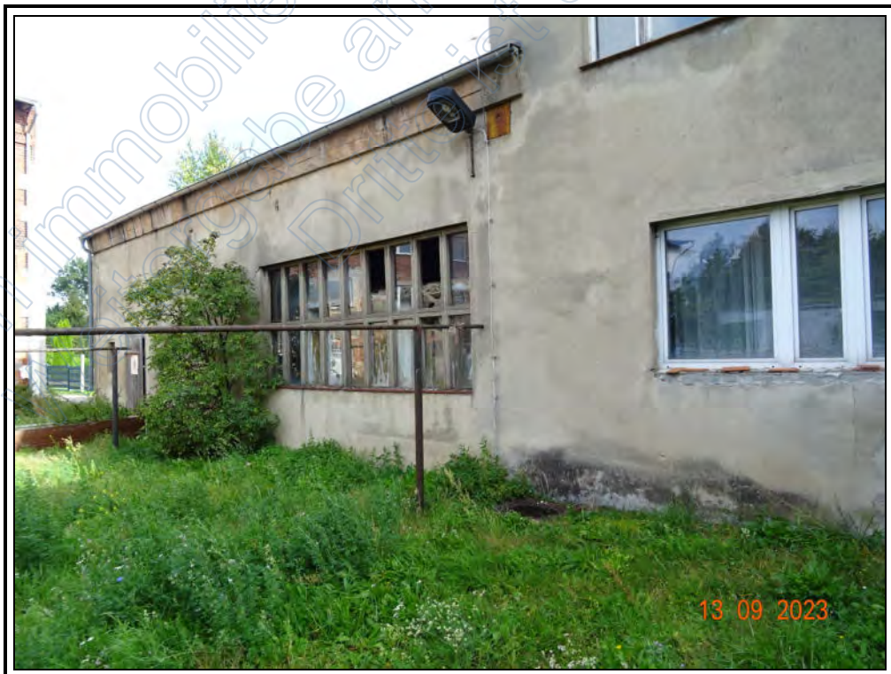
Foto 34: südliche Teilansicht des Heizhauses/ Verwaltungsgebäudes
