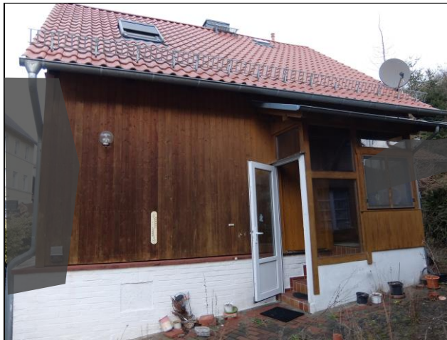
Ansicht von Süd-Ost
