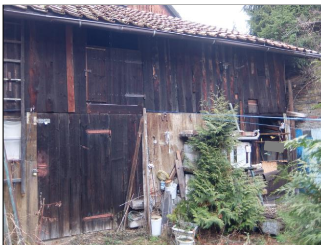
Ansicht Holzschuppen von Süd-Ost
