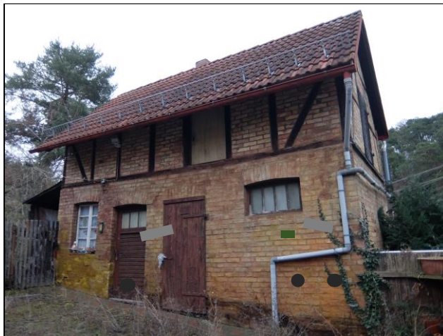
Ansicht Wirtschaftsgebäude von Westen
