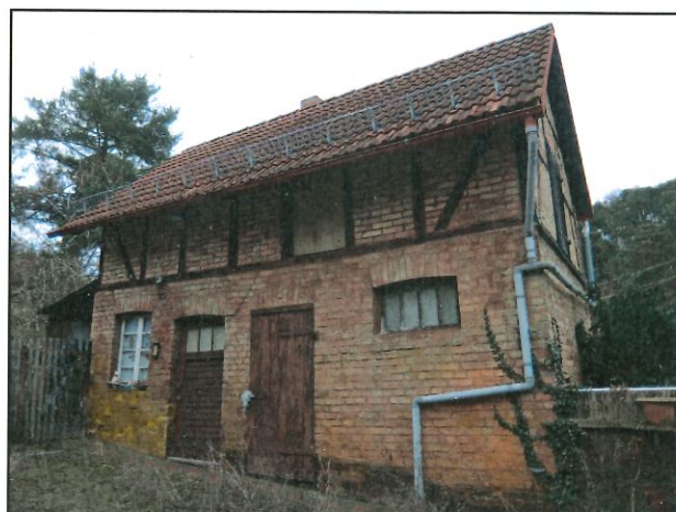
Ansicht Wirtschaftsgebäude von Westen
