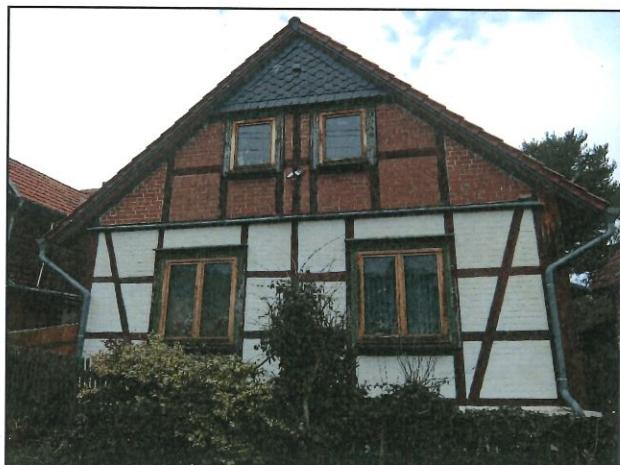
Ansicht von Süd-West
