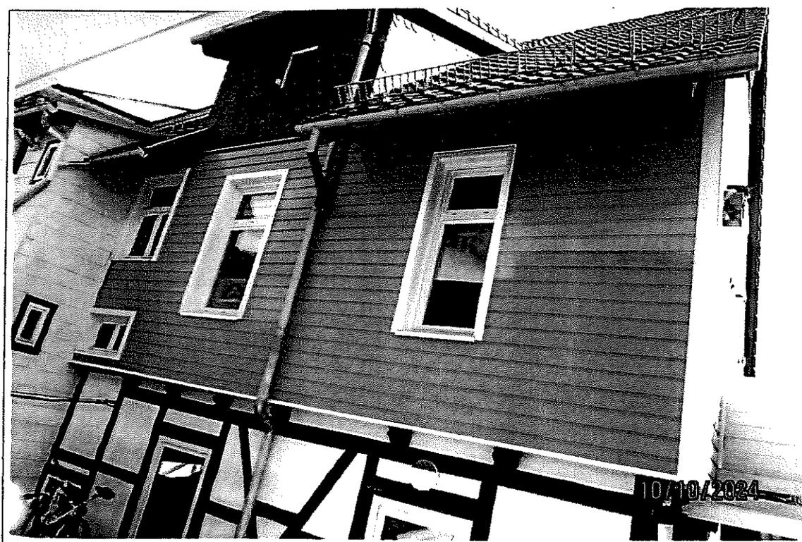
Abbildung 5: Hofansicht mit Außenwanddämmung im Obergeschoss.
