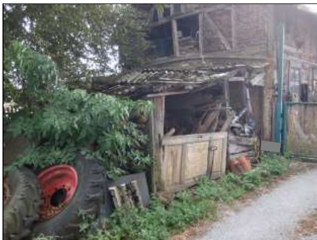
Ansicht Wirtschaftsgebäude von Nord-West
