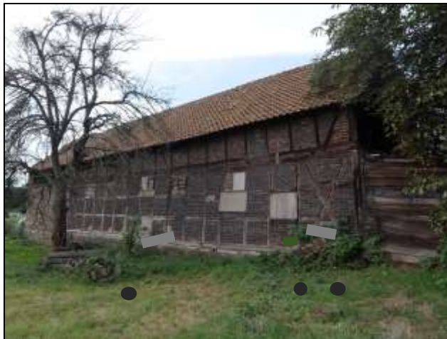
Ansicht Wirtschaftsgebäude von Nord-Ost
