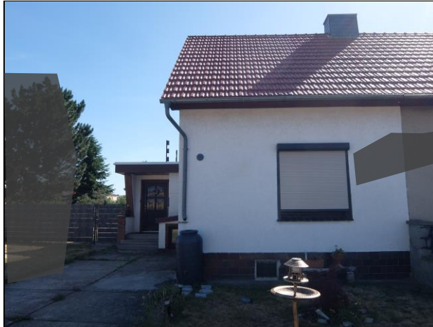
Ansicht von Süd-West
