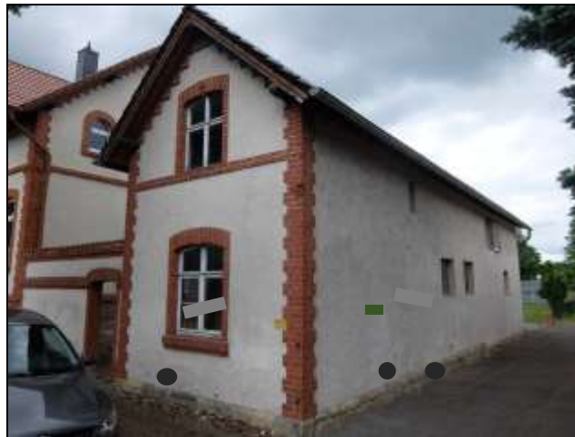
Ansicht Wirtschafts- u. Garagengebäude von Süd-Ost
