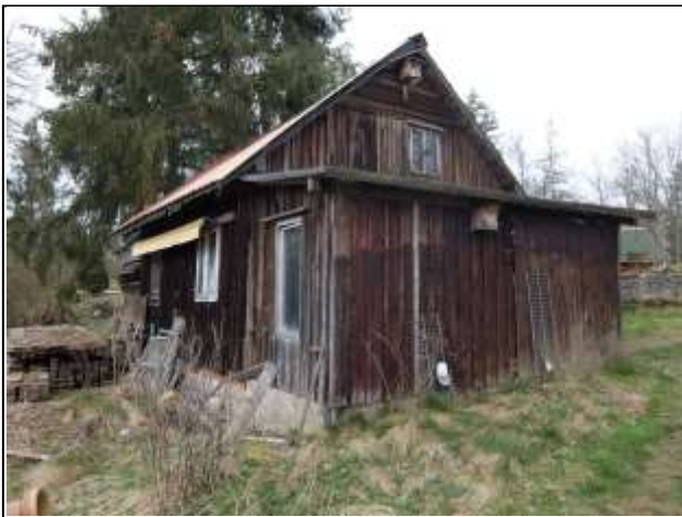
Ansicht Schuppen mit Anbauten von Osten
