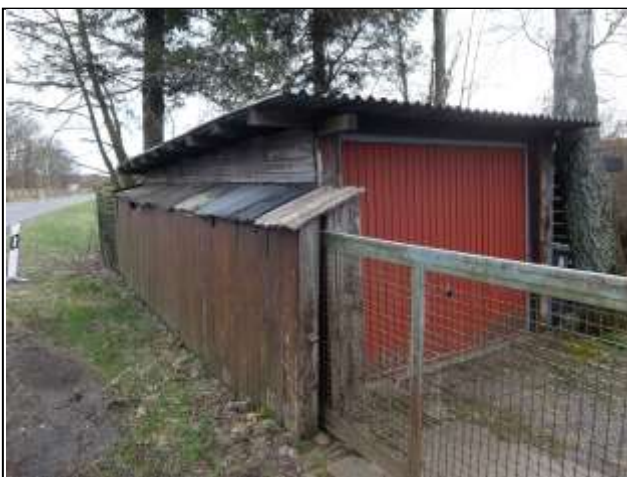
Ansicht Garage von Westen
