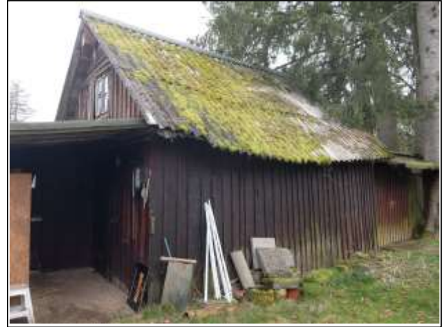
Ansicht Schuppen mit Anbauten von Norden
