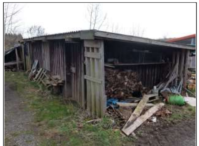
Ansicht Lagerschuppen von Westen
