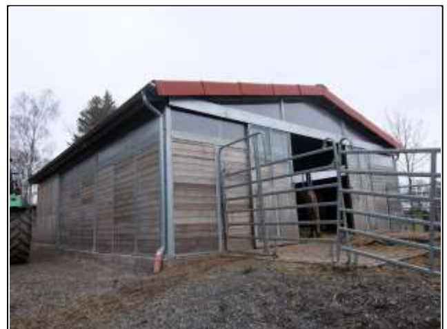
Ansicht Pferdestall von Süden
