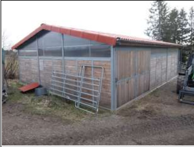
Ansicht Pferdestall von Norden
