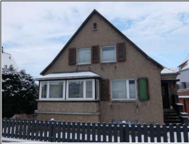
Ansicht von Süd-Ost
