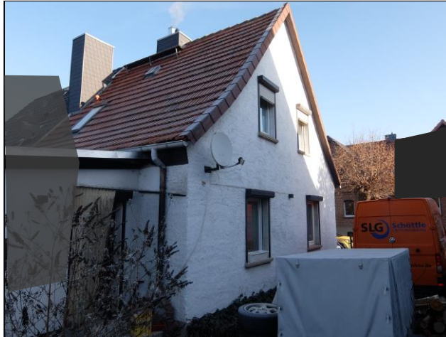
Ansicht von Süd-Ost
