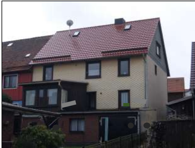
Ansicht von Norden
