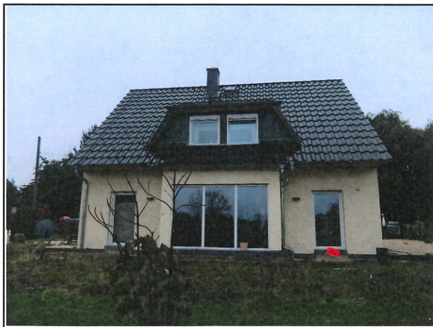
Ansicht von Norden
