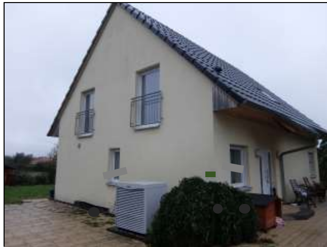
Ansicht von Süd-West
