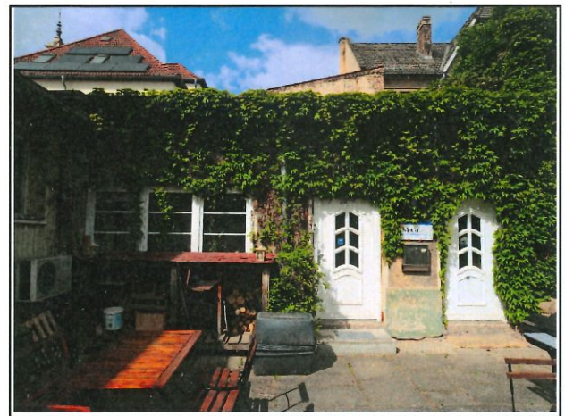
Ansicht Anbau von Osten
