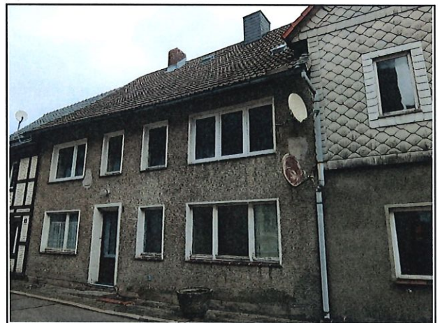
Ansicht Anbau von Süd-West
