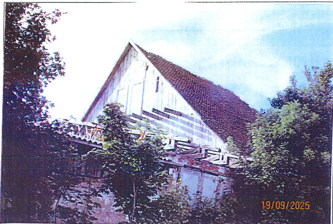
Abbildung 16: Teilansicht vom Nordostgiebel des Gebäudeteils Flurstück 54/3.
