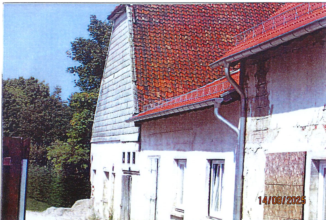
Abbildung 17: Teilansicht vom Südwestgiebel des Gebäudeteil Flurstück 54/3.
