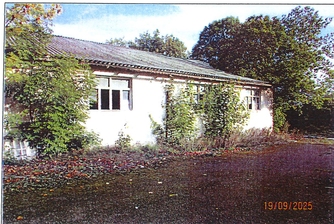
Abbildung 5: Teilansicht der Lagerhalle Flurstück 51/2
