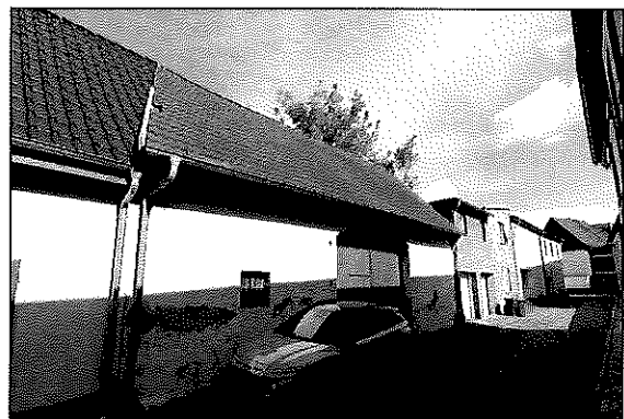
Ansicht des Bewertungsobjektes von der Hintergasse aus
