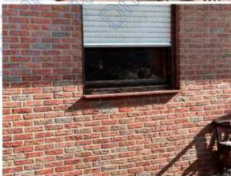
Bild 5: Feuchte- und Substanzschäden im Bereich der Fenster
