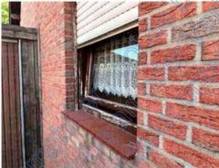
Bild 7: Feuchte- und Substanzschä- den im Bereich der Fenster
