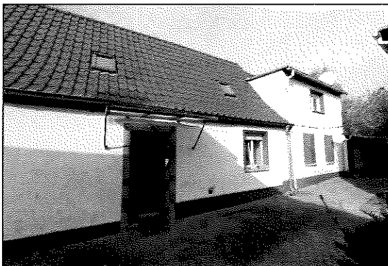
Ansicht des Wohnhauses vom Hof aus
