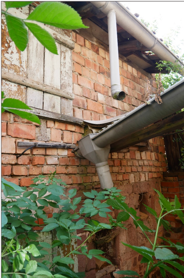
ehemaliger Stall - Hofansicht
