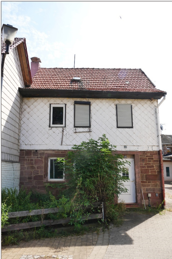
Wohnhaus - Westansicht (Straßenansicht)
