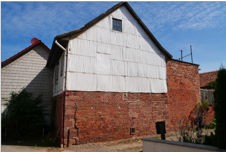
Wohnhaus mit Anbau - Südansicht
