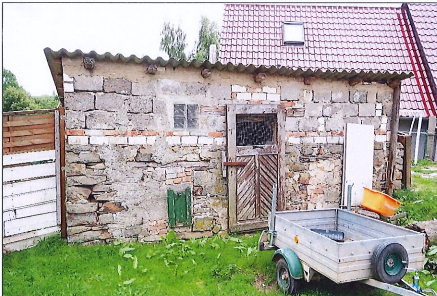
ehemaliger Hühnerstall - Nordwestansicht
