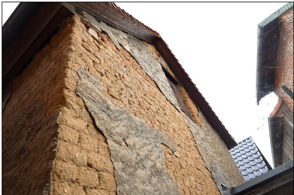
Südwestansicht – Einfamilienwohnhaus / Anbau
