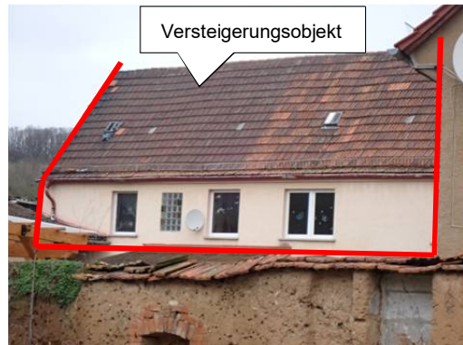
Blick etwa Richtung Nordwesten etwa südorientierte Fassade
