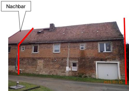
Ansicht von der Straße etwa nordorientierte Fassade
